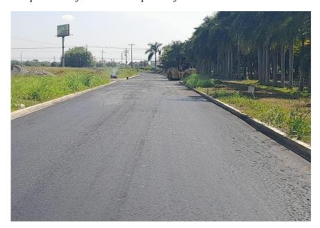
Al observar los resultados del ensayo de densidad en campo realizados a la base granular, presentados en la Tabla 3, se identificaron los puntos 8 y 13 como aquellos que no cumplieron con el porcentaje de compactación requerido por el ingeniero diseñador. A pesar de esto, durante el proceso constructivo no se observaron irregularidades visuales que pudieran indicar problemas, según las Especificaciones Generales de Construcción de Carreteras de INVIAS (INVIAS, 2012a; Mancera, 2017).
