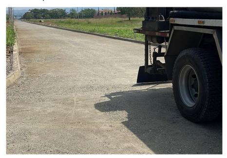
Por otro lado, es crucial controlar la cantidad de pasadas del equipo de compactación. Si se realizan menos pasadas de las necesarias, no se logrará la densidad requerida, comprometiendo la calidad de la vía. Sin embargo, un exceso de pasadas puede llevar a la segregación de los materiales, como señala (Chen et al., 2020). La sobrecompactación puede ser identificada por la separación visible entre los materiales finos y gruesos, lo que no solo afecta la estructura del
