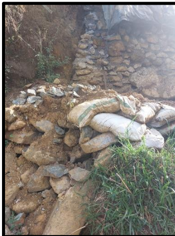
Figura 17. Muros de contención artesanal.
