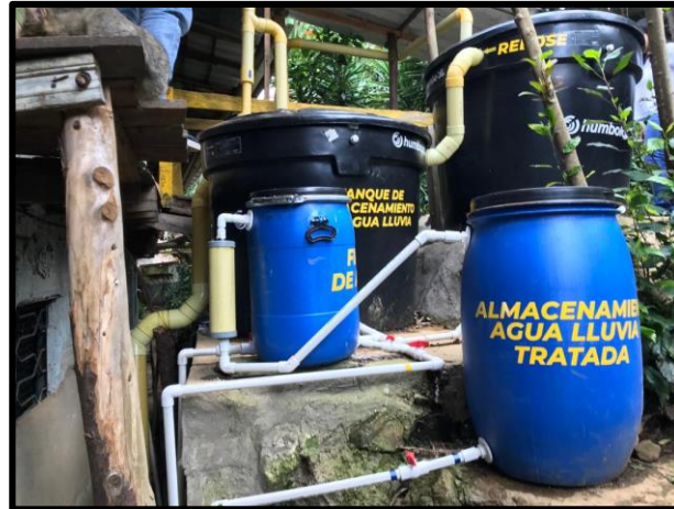
Figura 22. Sistema de Agua Lluvia del sector El Palomar en Teofanía.
