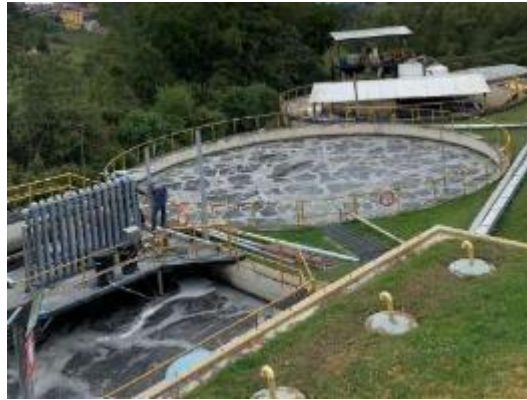
Figura 10. Proceso biológico Planta de tratamiento CRUSTAL S.A.S
