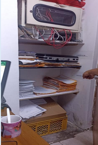
Archivadores y caja sin rotular
