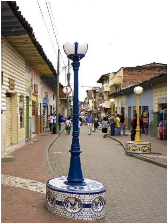
Fotografía 1: Calle de la Cerámica en sentido Sur-Norte.
