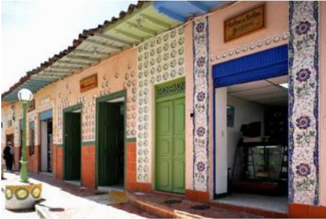
Fotografía 5 Estética original de las fachadas de la Calle de la Cerámica
