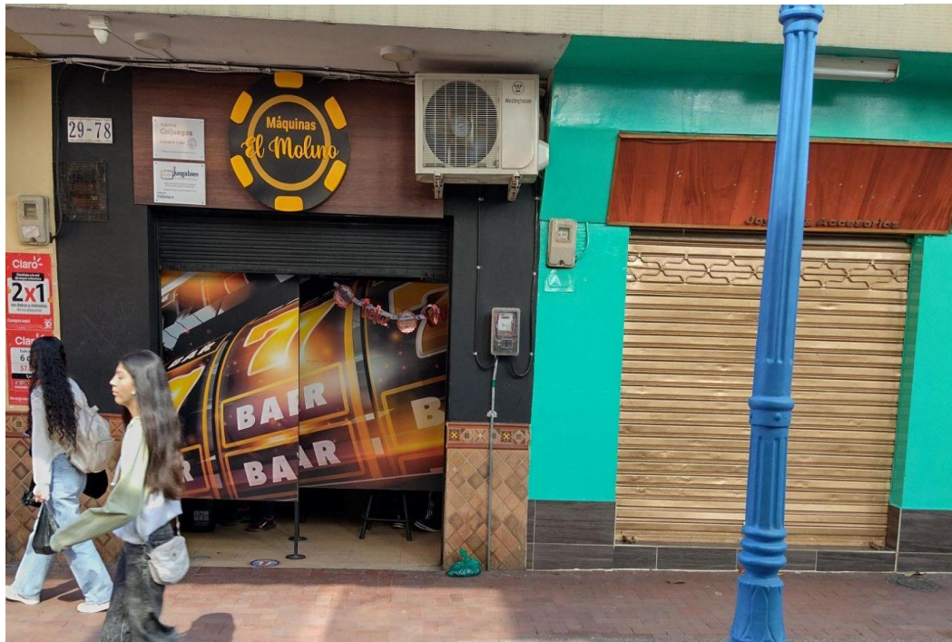
Fotografía 6 Intervención sobre fachadas de la Calle de la Cerámica
