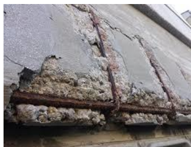
Figura 9. Químicas - Oxidación Fuente. (Hume Ingeniería, 2015)
