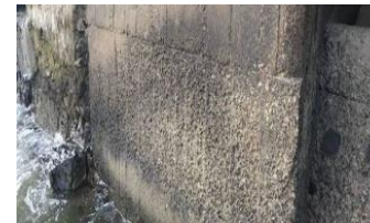
Figura 4. Física – Erosión por Cavitación
