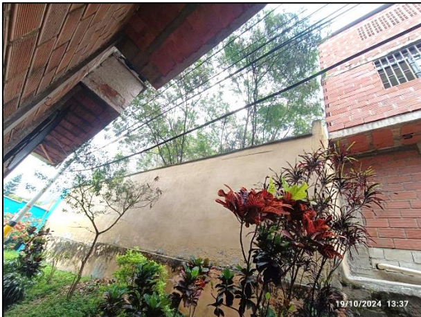
Figura 27. Panorámica de muro colegio colindante.
