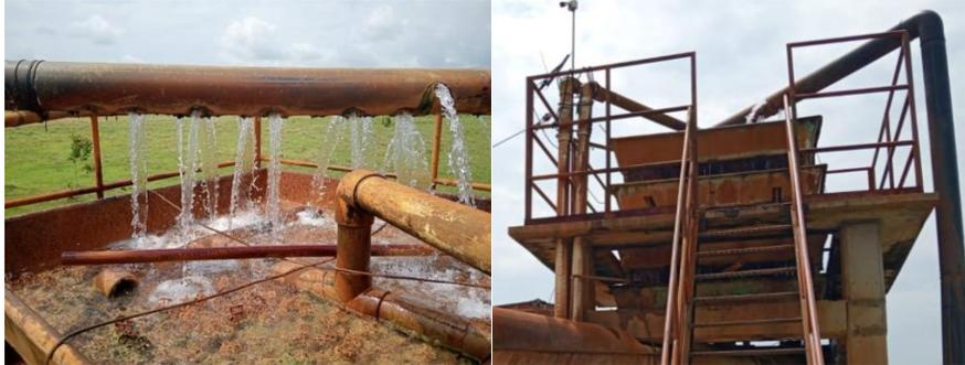
Nota: Imagen tomada las bandejas de aireación de El Reposo, en donde se muestra la composición de estas y el ingreso del agua cruda a la planta.
