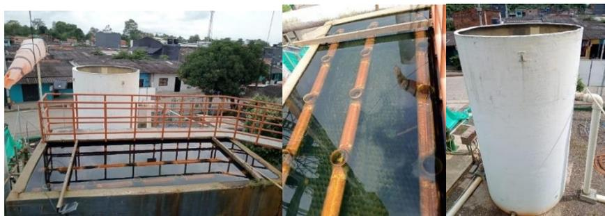
Sumado a las purgas diarias realizadas a los sedimentadores, es necesario realizar un lavado o un mantenimiento, que conlleva al descargue total del tanque sedimentador, este proceso genera un mayor volumen de descarga de lodos.
