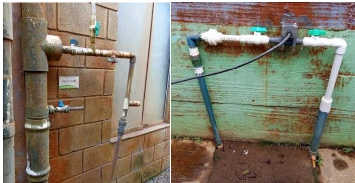
Nota: La pre-cloración se realiza en la red de tubería como se muestra en la imagen, con cloro gaseoso previo a las bandejas de aireación.
