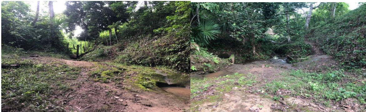
Figura 30. Evidencia del seguimiento del punto crítico "Pozo el Aguá".
