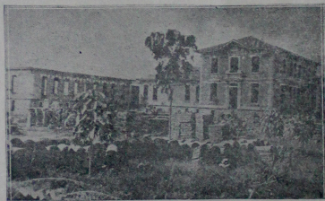
Kotak J. Echavarría HOSPITAL DE SAN VICENTE DE PAUL Pabellón de Cirugía
