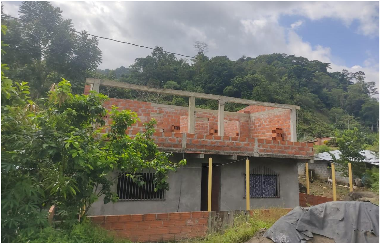
Fotografía 12. Vivienda en construcción NAR San José de León
