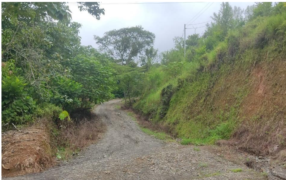
Fotografía 10 Vía de ingreso a Becuarandó
