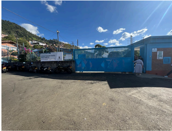
Figura 2. Entrada del Colegio Sagrada Familia Aldea Pablo VI. Fuente. Fotografía tomada en el trabajo de campo.
