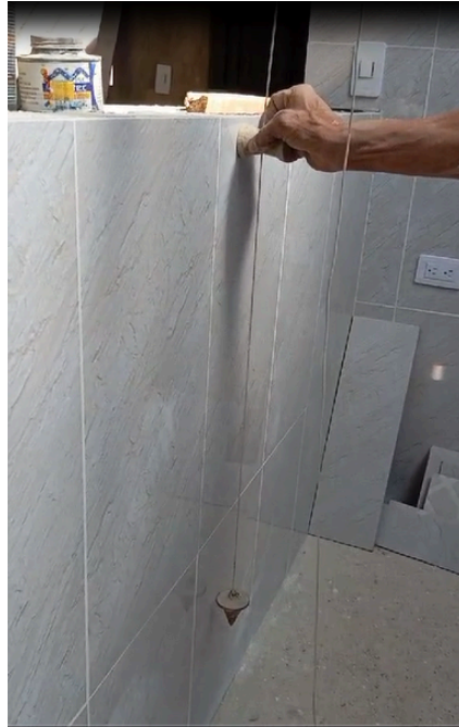
Figura 6. Uso de la plomada en verificación de perpendicularidad.
