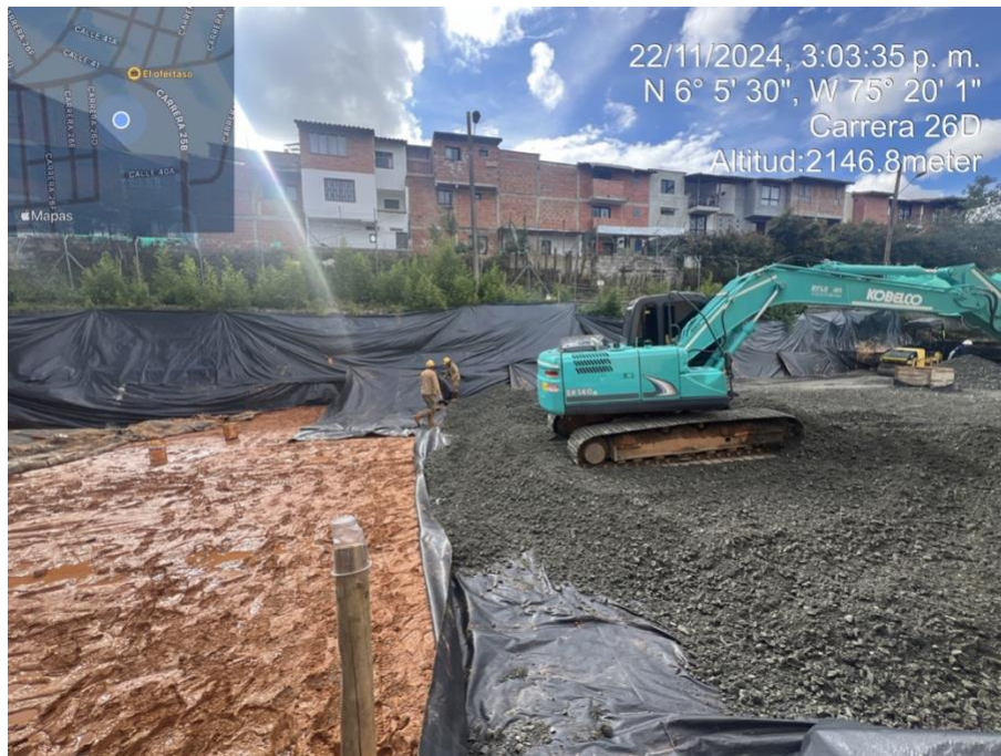
Figura 13. Instalación geotextil y reemplazo en base granular segunda etapa del proyecto “Villa del Carmen”.
