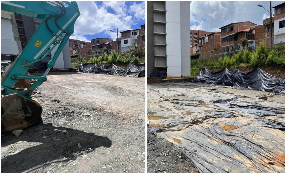
Figuras 16 y 17. Fin primera capa base granular y colocación de plástico para protección de lluvias “Villa del Carmen”.
