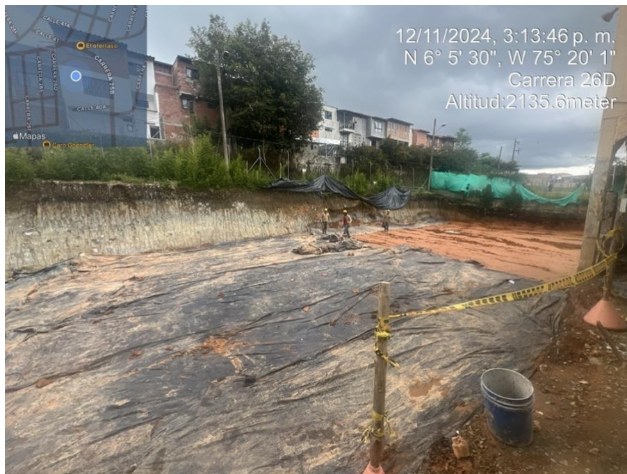
Figura 10. Instalación de plástico para protección de limo segunda etapa del proyecto “Villa del Carmen”.
