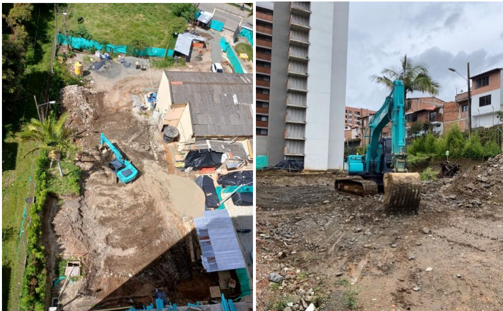
Figuras 4 y 5. Inicio de actividades adecuación de terreno segunda etapa del proyecto “Villa del Carmen”.
