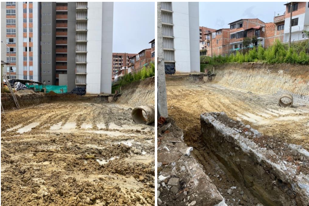
Figuras 7 y 8. Fin de excavaciones segunda etapa del proyecto “Villa del Carmen”.
