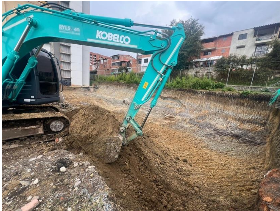
Figura 6. Excavaciones segunda etapa del proyecto “Villa del Carmen”.
