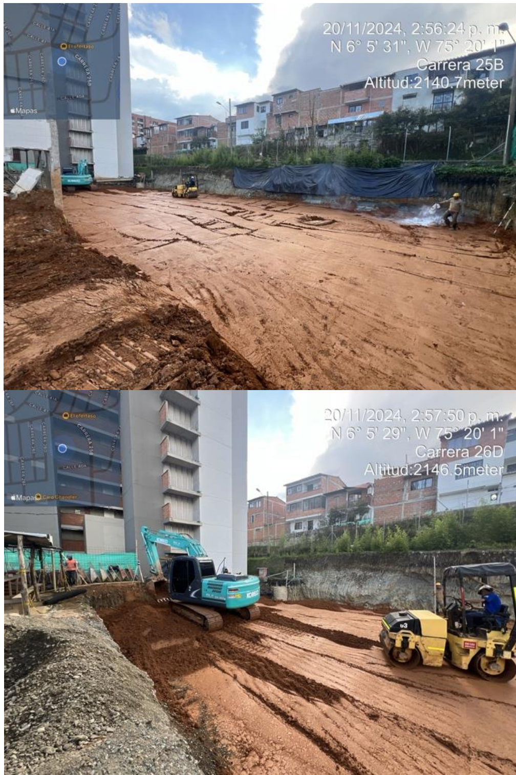
Figuras 11 y 12. Compactación de material limo segunda etapa del proyecto “Villa del Carmen”.
