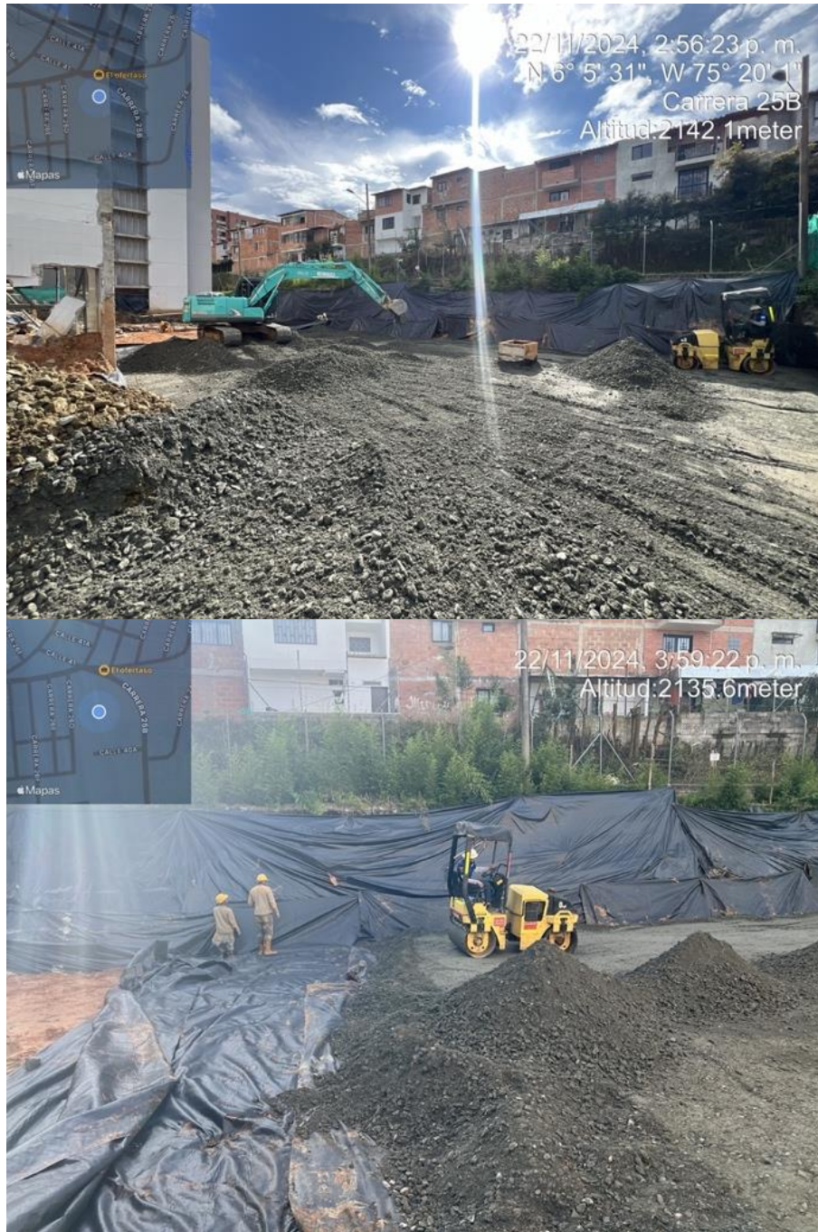
Figuras 14 y 15. Extensión y compactación primera capa base granular del proyecto “Villa del Carmen”.
