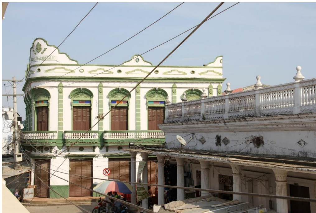
Imagen 5. Edificio La Isla a la derecha y Edificio Mercedes María de Caraballo al fondo
