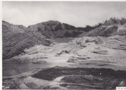
Limpieza de fundación de la represa secundaria
