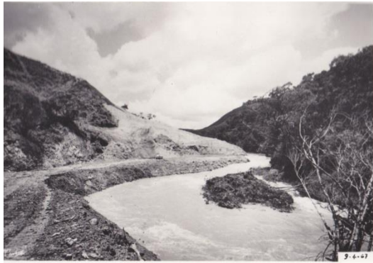
Excavación de la zona de salida del vertedero
