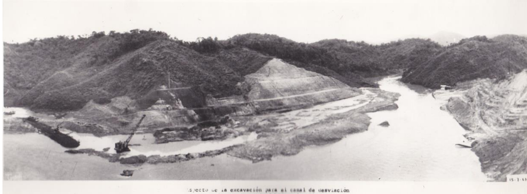
Aspecto de la excavación para el canal de desviación
