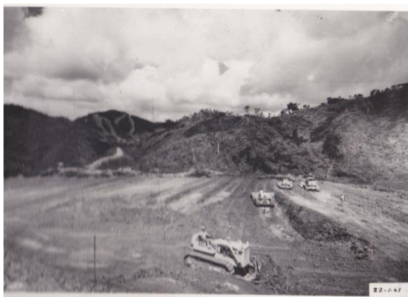
Excavaciones para el canal de desviación
