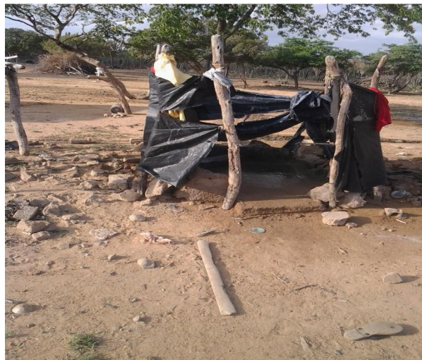
Figura 36. Fotografía baño Wayúu en malas condiciones
