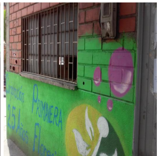
Fachada Primer piso 1
