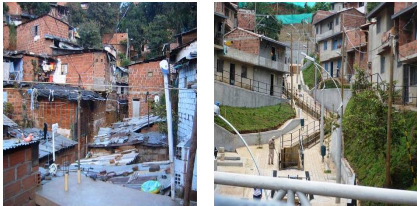
Imagen 10 Canalización y mejoramiento de vivienda. Antes y después PUI
