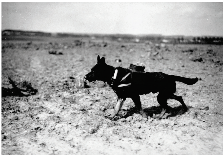
Ilustración 6. Perro mensajero con un carrete sobre el lomo trazando una nueva línea eléctrica (A messenger dog with a spool attached to a harness for laying out new electric line in September of 1917).
