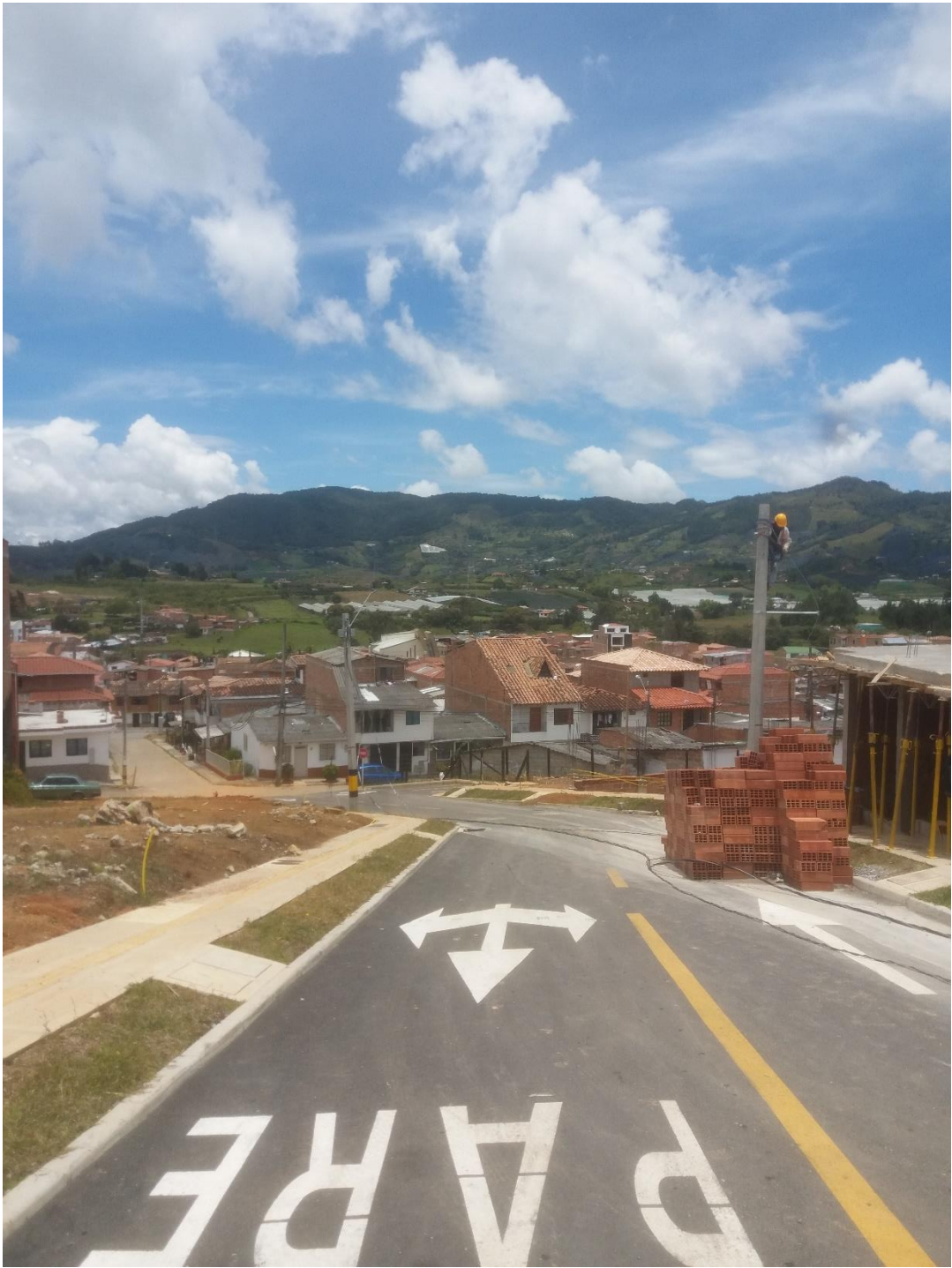
Imagen D. 5. Instalación de vestidas de los postes y montaje del conductor
