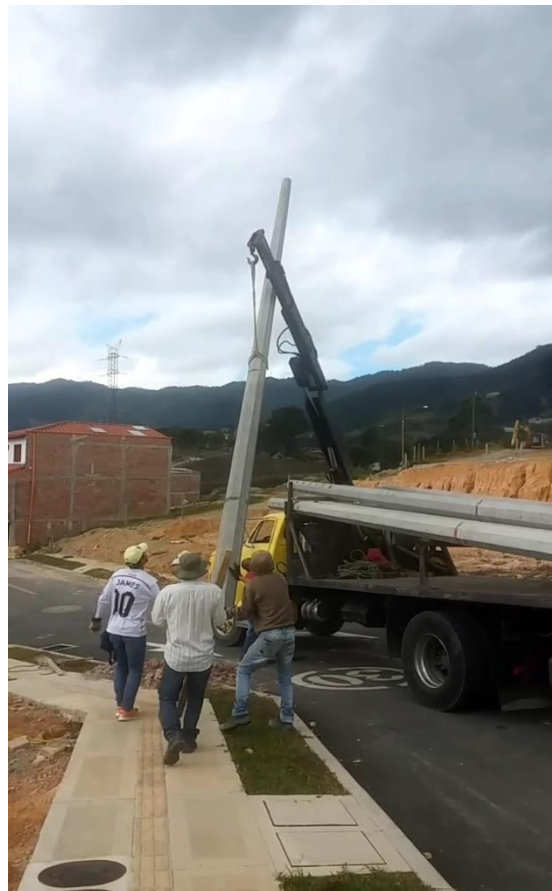
Ilustración 2. Montaje de Postes.
