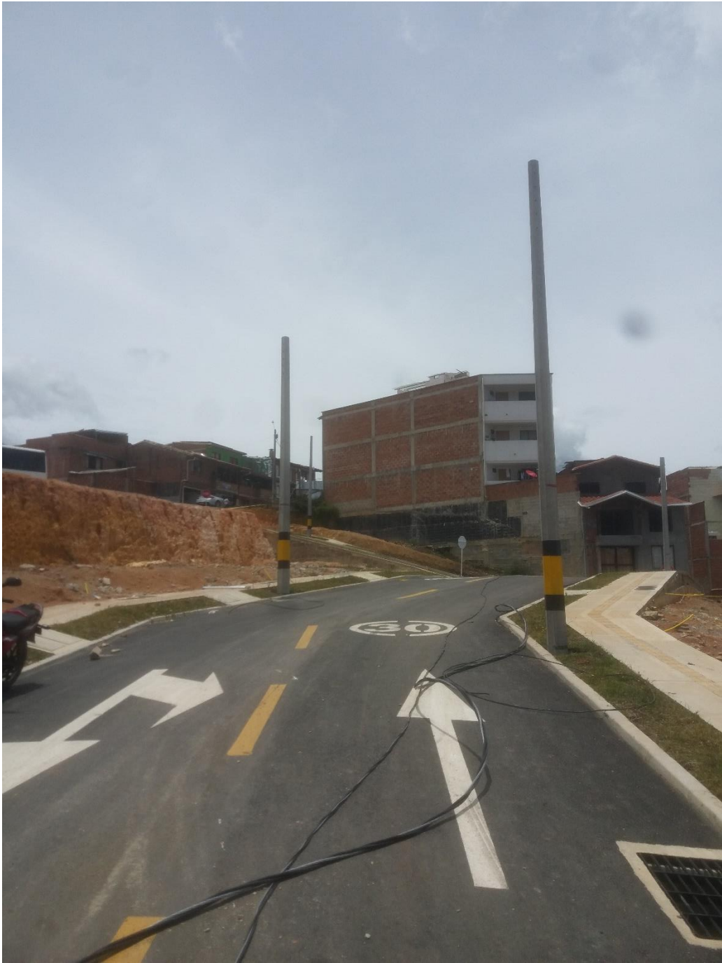
Imagen D. 4. Tendido de cableado.
