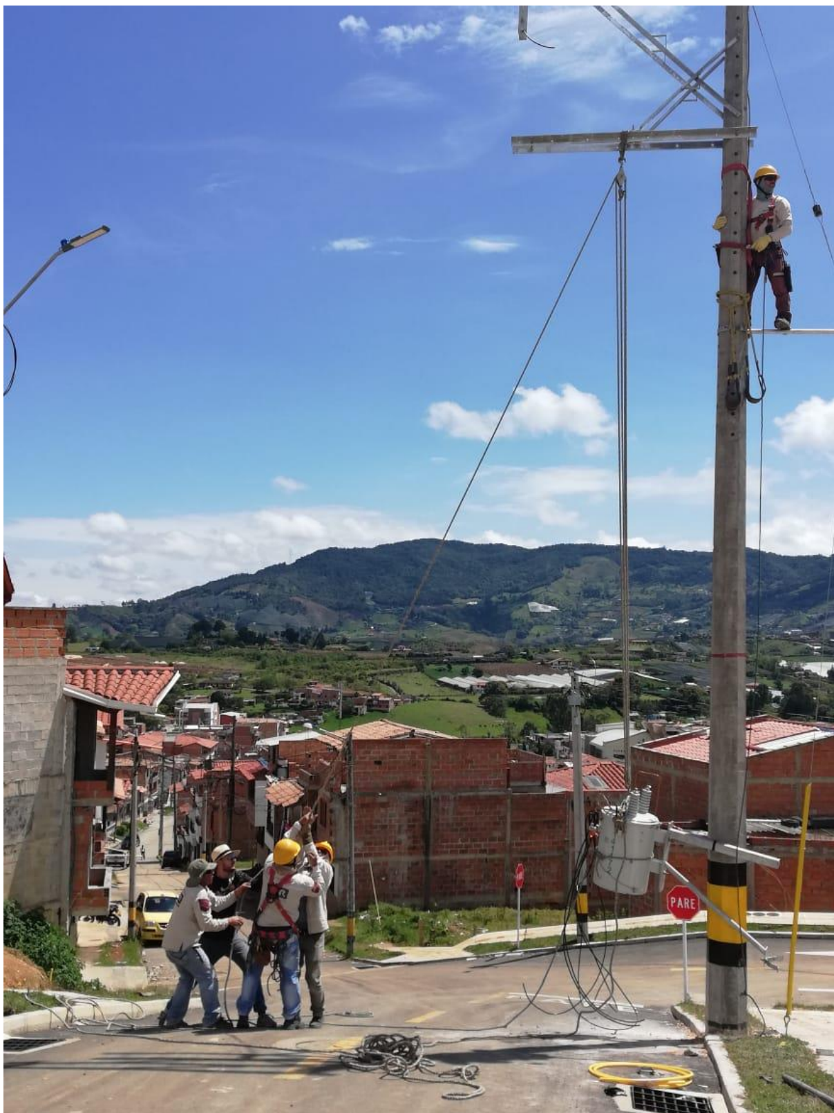
Imagen D. 6. Instalación Transformador de 75 kVA monofasico.
