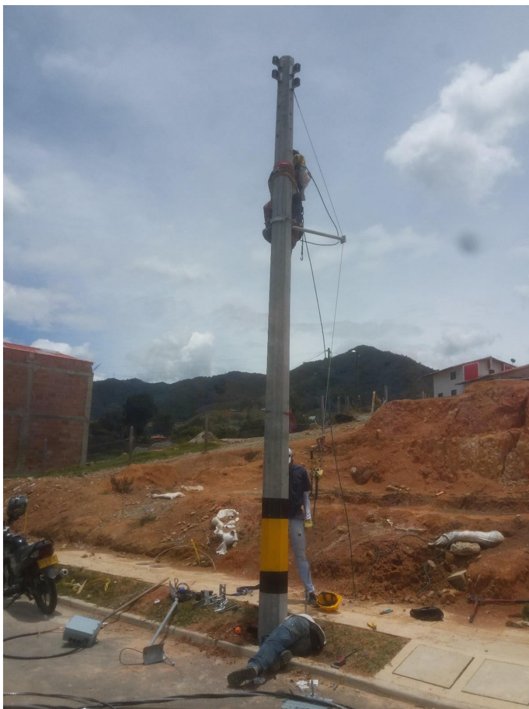
Imagen D. 2. Instalación de puesta a tierra de los postes.
