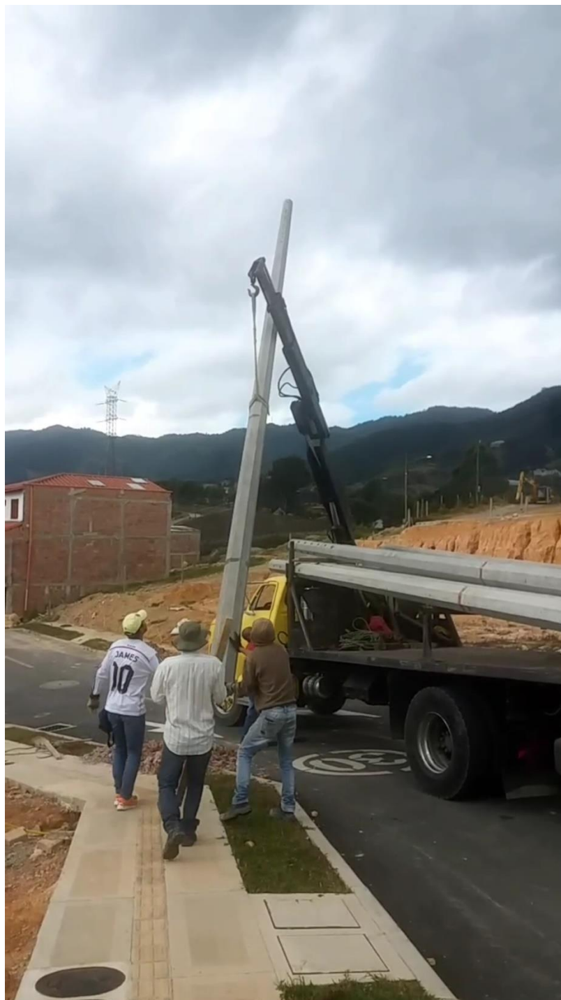
Imagen D. 1. Instalación de postes de concreto de 8 metros.
