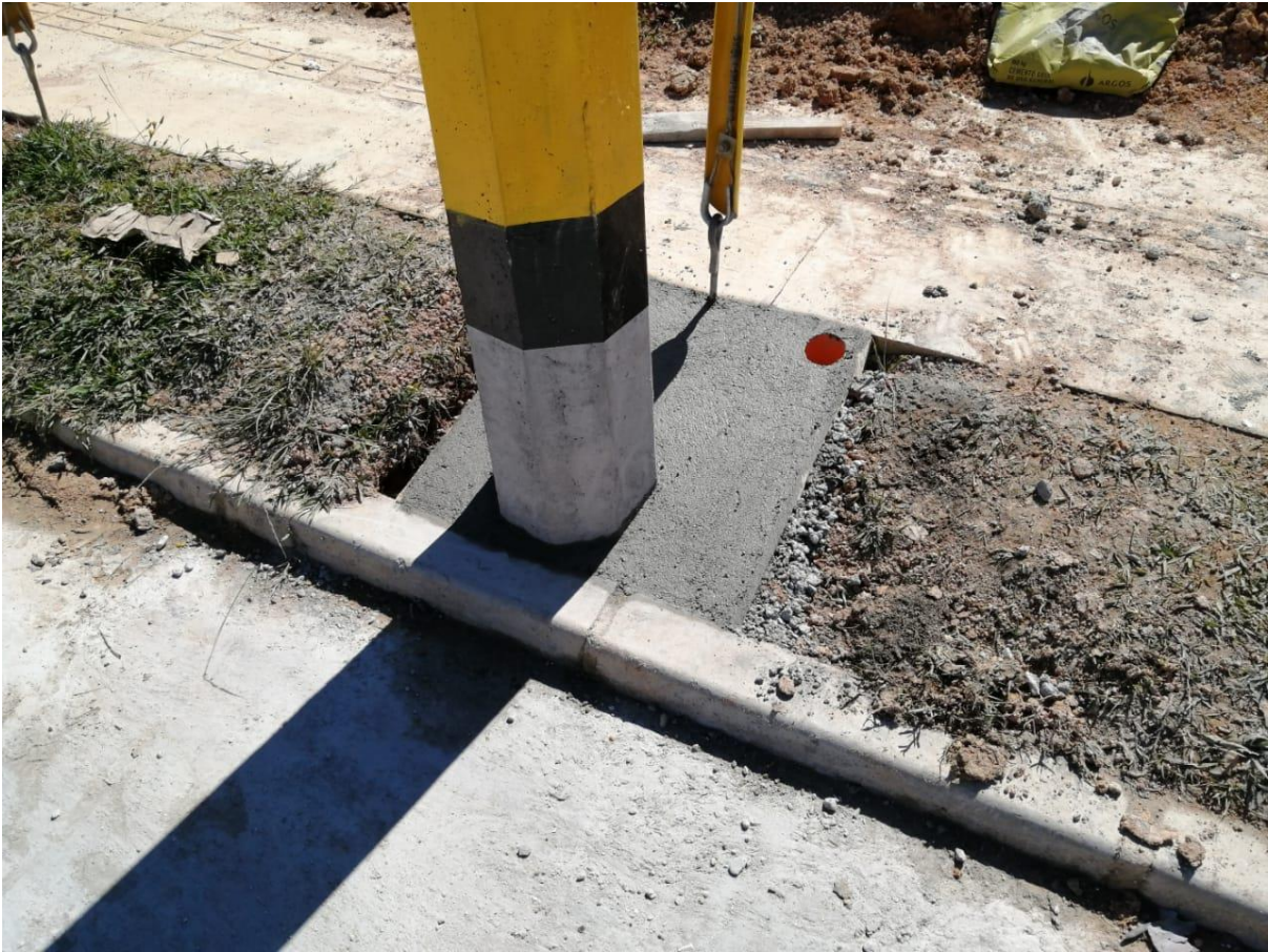
Imagen D. 3. Vaciado de concreto para los postes.
