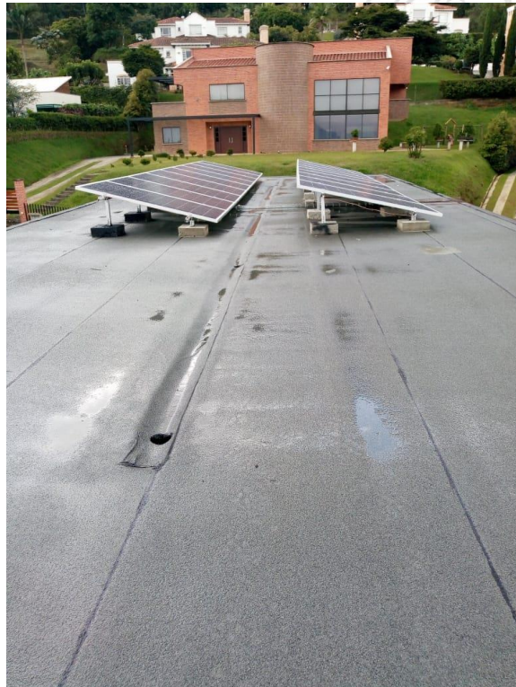
Fig. 23. Instalación de paneles solares.
