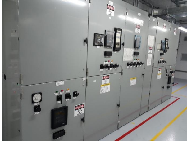
Figura 45. CCM ciclo com binado, celdas 4160 V.
