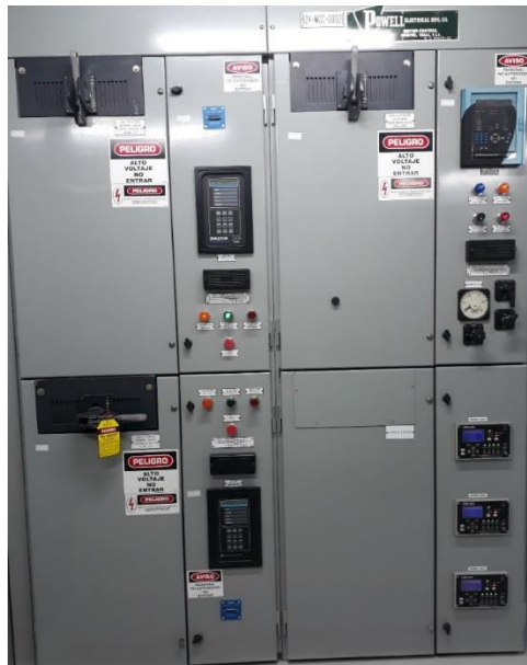
Figura 54. CCM Intake, celdas 4160V lado derecho.
