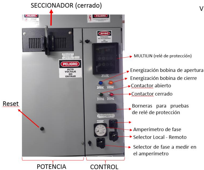
Figura 60. Celdas de control CCM Ciclo Combinado para transformadores.
