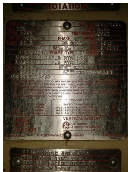
Figura 39. Placa motores de condensado.
