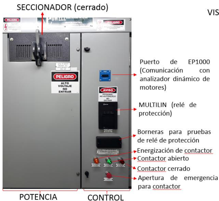
Figura 61. Celdas de control CCM Ciclo Combinado para bombas de condensado.
