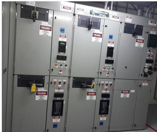
Figura 49. CCM Ciclo combinado, celdas 4160V lado izquierdo.
