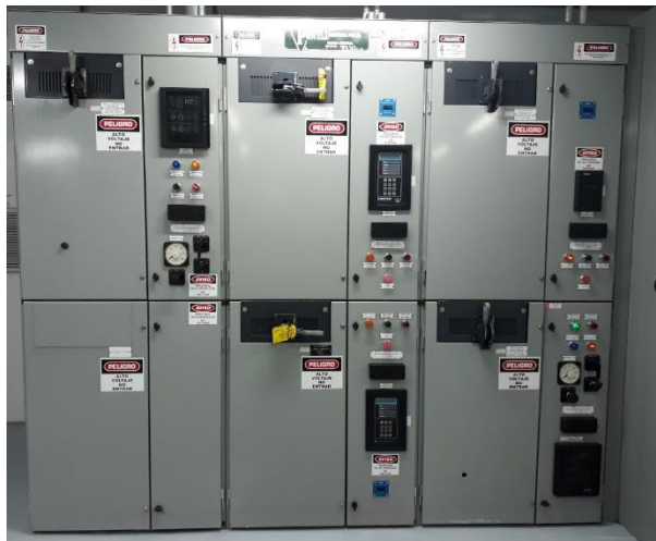
Figura 47. CCM Ciclo combinado, celdas 4160V lado izquierdo.
