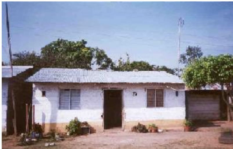
Foto # 13: Vivienda del Puerto.
