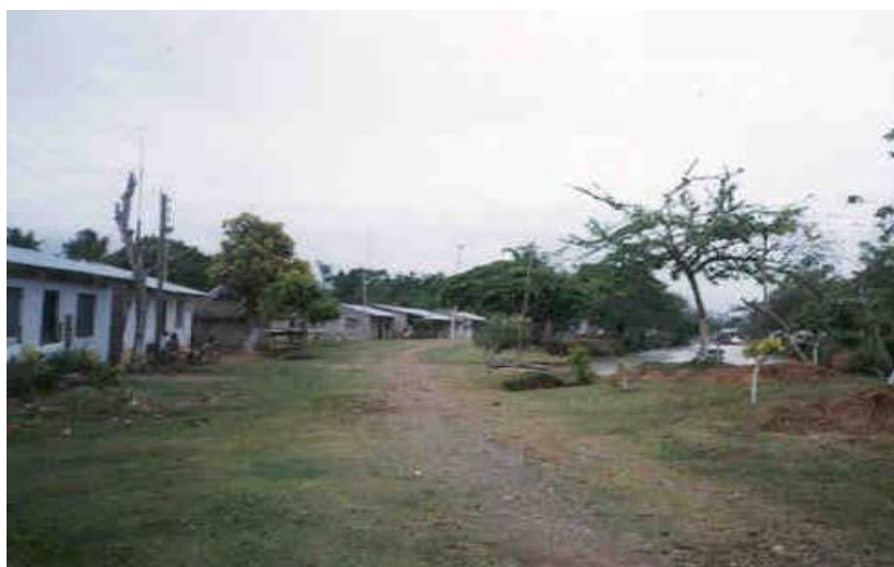
Foto #12: Actual condición del Puerto
