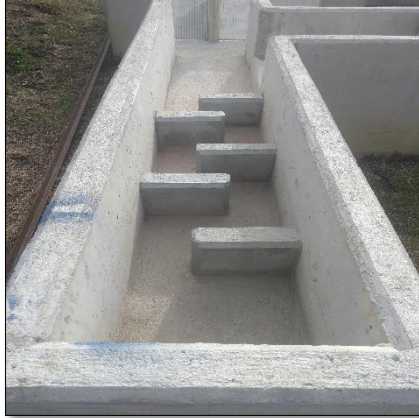
Foto 1. Canal de entrada con disipadores de energía Tomada por: Santiago Londoño
