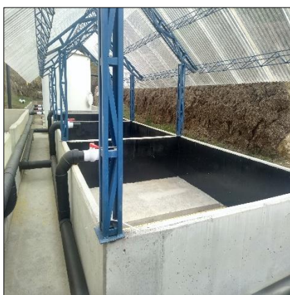
Foto 9. Lechos de secado Tomada por: Santiago Londoño
