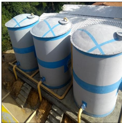
Foto 30. Filtros anaerobios de flujo ascendente (FAFA) Tomada por: Santiago Londoño
