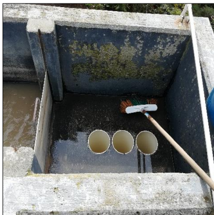
Foto 24. Vertedero de excedentes (Aliviadero) Tomada por: María Camila Gómez
