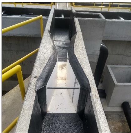
Foto 5. Canaleta Parshall de 6'' Tomada por: Santiago Londoño
