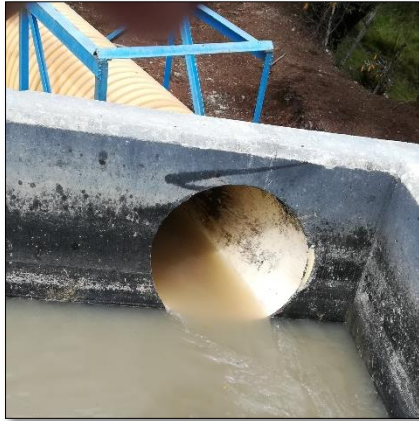
Foto 22. Alcantarillado combinado Tomada por: María Camila Gómez
