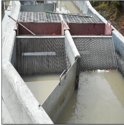
Foto 25. Unidad de cribado (con pasarela y canastillas) Tomada por: María Camila Gómez
