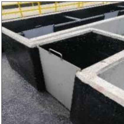
Foto 6. Vertedero lateral después de unidades preliminares Tomada por: Laura Patiño
