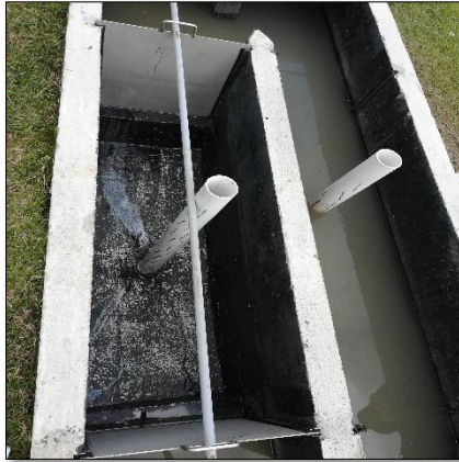
Foto 13. Canales desarenadores Tomada por: Maria Camila Gómez
