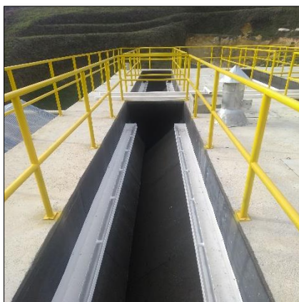
Foto 7. Reactor UASB y quemador de biogás Tomada por: Santiago Londoño
