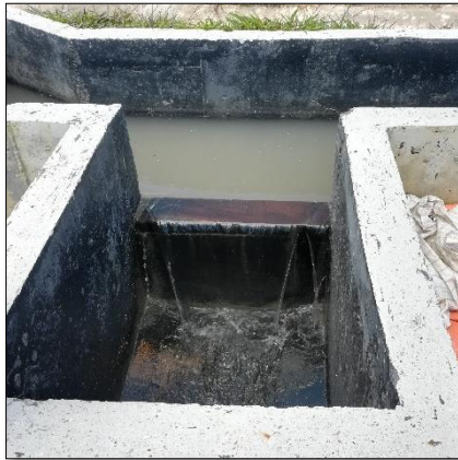
Foto 11. Vertedero lateral o de excesos Tomada por: María Camila Gómez
