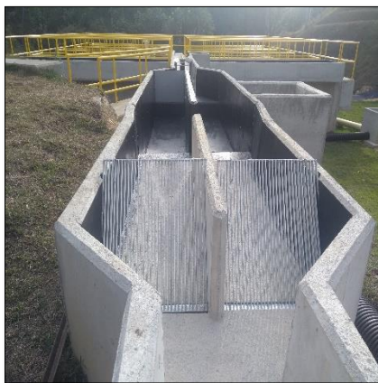
Foto 3. Unidad de cribado (sin canastillas ni pasarela) Tomada por: Santiago Londoño
