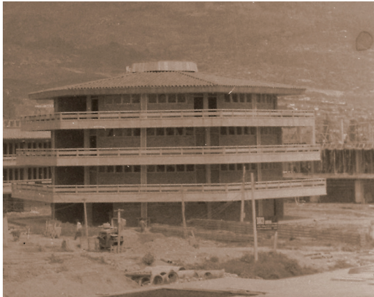
Bloque 11 en construcción
