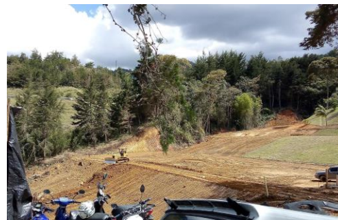
Foto 10. Bosque talado para la construcción de caballerizas, 31 de marzo de 2019. Foto personal.
