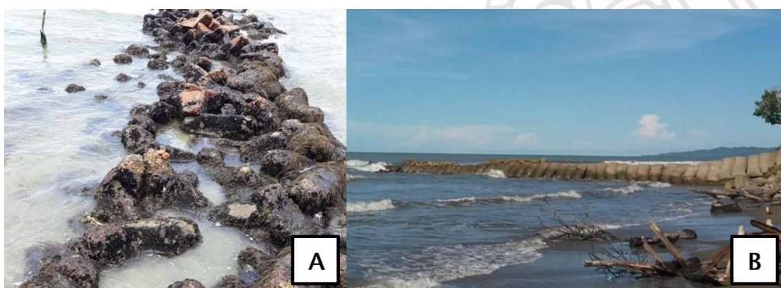
Figura 11. Obras estructurales del municipio de San Juan de Urabá. A) Espolón en roca. B) Espolón en bolsacreto
