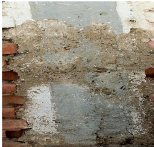
Figura 27. Representación del escamado. Tomado de: Jiménez, 2016
