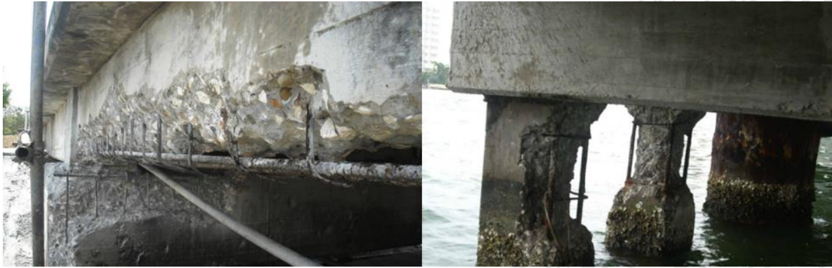
Figura 29. Representación de la exposición del acero. Tomado de: (ARGOS 360, n.d.)
