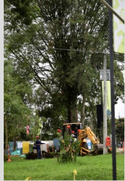
Figura 23. Trabajo de campo momento en que se está zanjeando con maquinaria para posterior derribo de un árbol inmenso en el sector del comando del barrio El Porvenir. Elkin García (2017).
