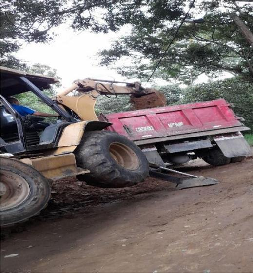
Imagen 15. Vehículo y máquina para recolectar lo RCD
