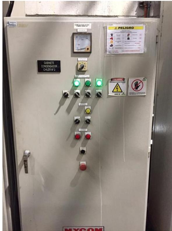
**Figura 9.** Gabinete al que se le cambió la etiqueta de arco debido al deterioro que presentaba.
