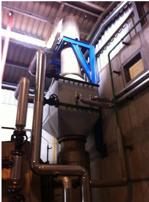
**Figura 34. montaje del economizador en una caldera pirotubular. (Calderería López Hermanos, 2014)**
