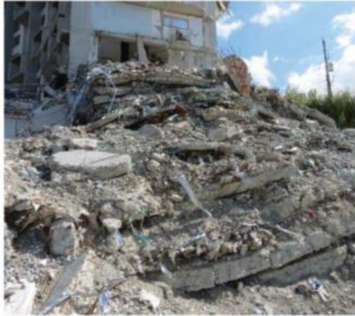
Figura 8 Escombros después del desplome de la torre 6. Tomada de: https://www.facebook.com/ElColombiano/posts/529830203773690/
