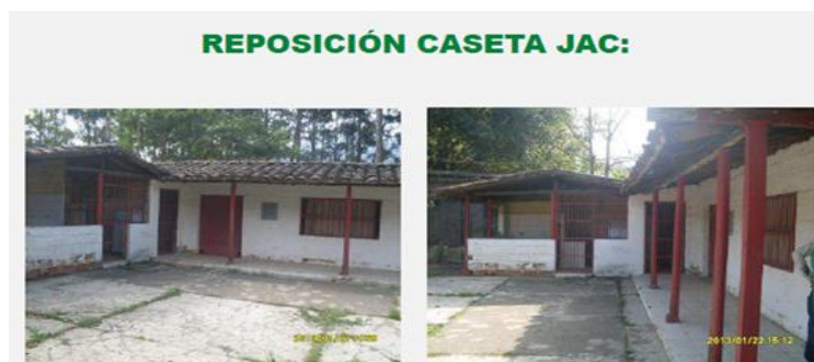
Figura 3 Reposición caseta JAC
