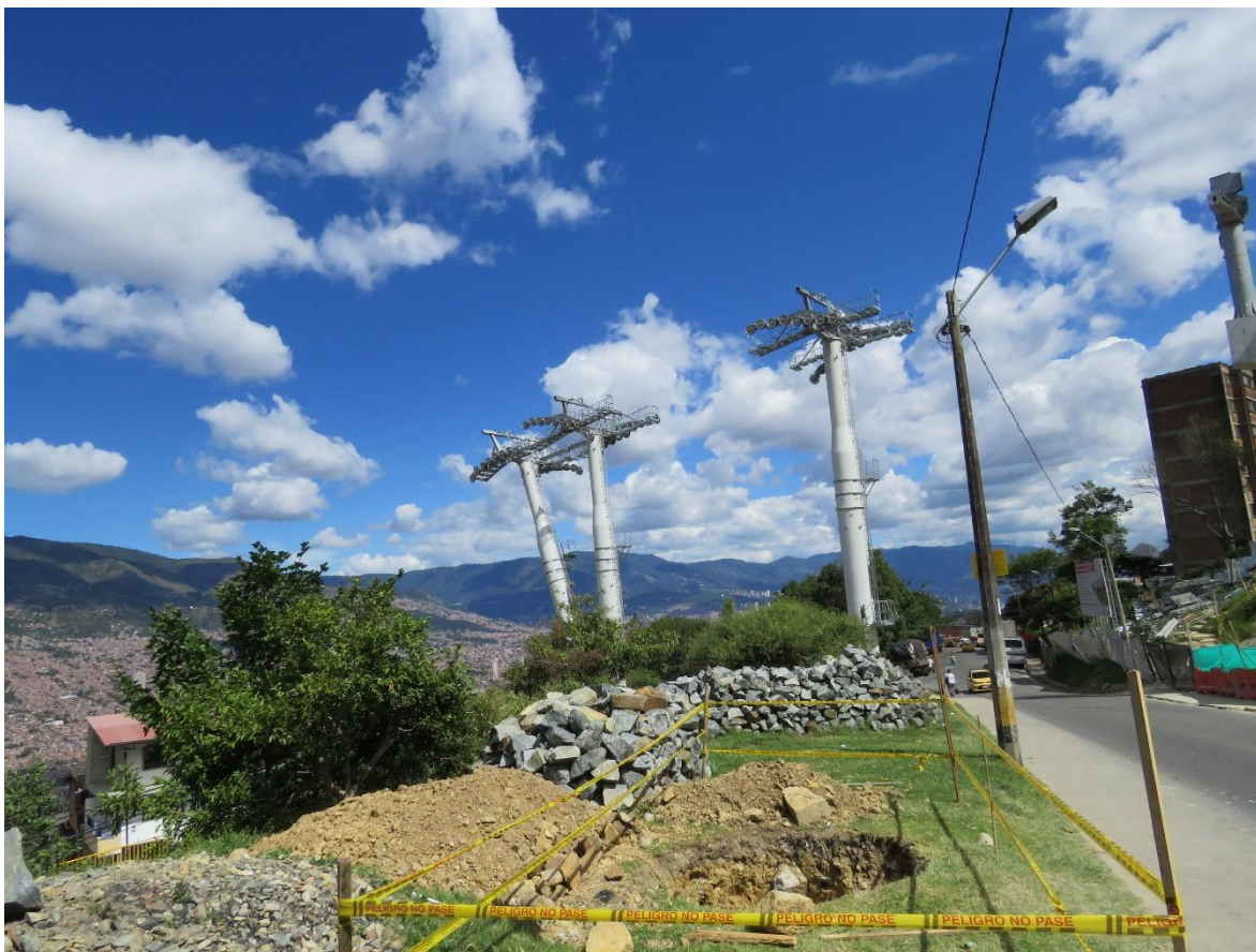
Fotografía 14. Avance en la construcción de la Línea de Cable El Picacho de la Empresa Metro de Medellín Fuente: registro fotográfico personal. Tomada 4 de agosto de 2019
