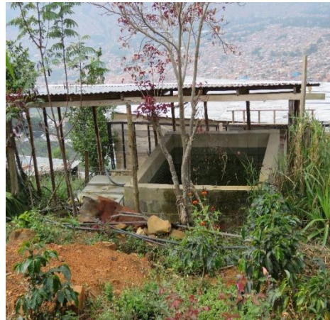
Fotografía 25. Tanque de agua para el consumo y tuberías surtidoras. Fuente: Registro fotográfico personal. Tomada 18 de mayo de 2019
