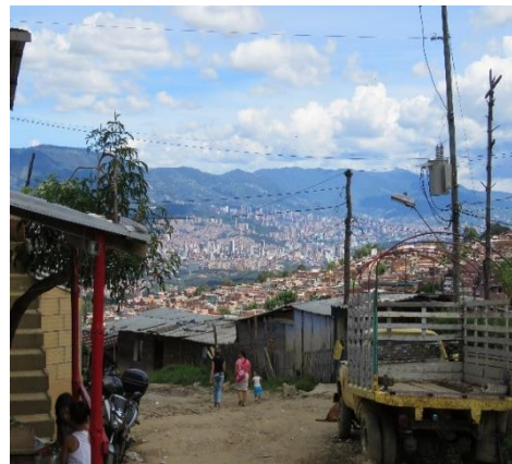
Fotografía 27. Conexiones a energía Fuente: Registro fotográfico personal. Tomada 10 de julio de 2017
