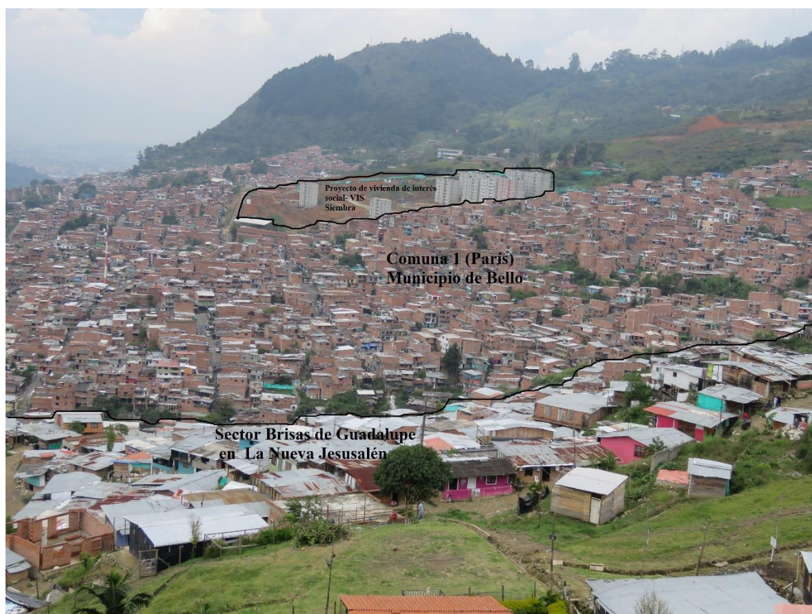
Fotografía 13. Avance del proyecto de vivienda de interés social VIS - Siembra (Barrio Paris, Comuna 1, Municipio de Bello) y una parte del sector Brisas de Guadalupe de La Nueva Jerusalén, (vereda 11 Potrerito, Municipio de Bello) Fuente: modificada a partir de registro fotográfico personal. Tomada desde La Nueva Jerusalén, 18 de mayo de 2019
