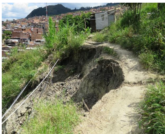
Fotografía 20. Deslizamiento de tierra en borde de camino Fuente: Registro fotográfico personal. Tomada 10 de julio de 2017
