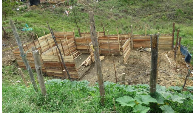
Fotografía 11. Casa de madera en construcción en La Nueva Jerusalén Fuente: registro fotográfico personal. Tomada 18 de mayo de 2019
