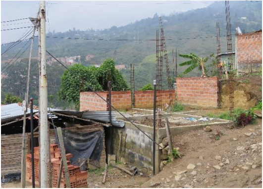
Fotografía 10. Casa de material definitivo en construcción en La Nueva Jerusalén Fuente: registro fotográfico personal. Tomada 18 de mayo de 2019
