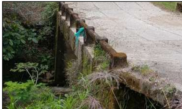
Figura 12 Pontón con problema de socavación.
