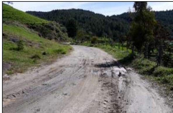
Figura 21 Zona con hundimiento de banca
