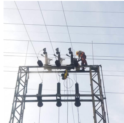
Fig. 24. Mantenimiento a pórtico.
