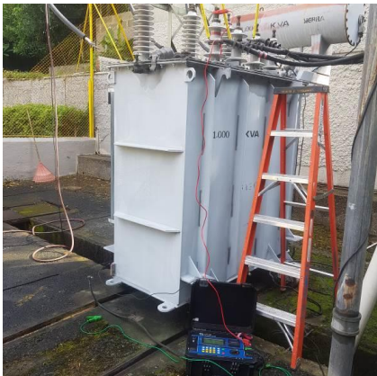
Fig. 22. Prueba de resistencia de aislamiento.
