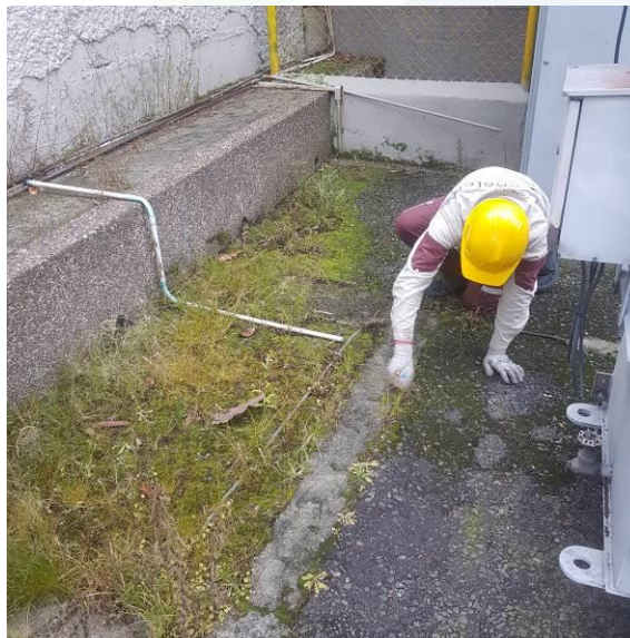
Fig. 16. Desmalezada de subestación.
