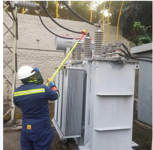
Fig. 7. Verificación de ausencia de tensión al transformador.
