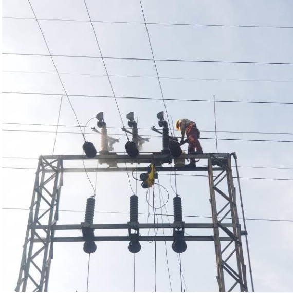
Fig.22. Limpieza de pórtico en subestación.
