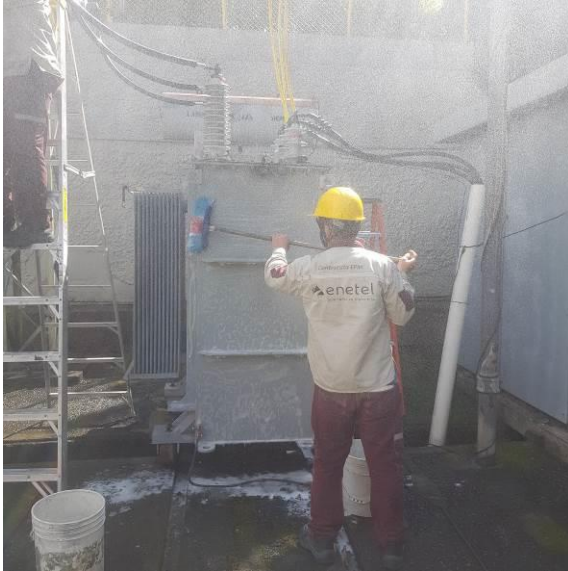
Fig.26. Limpieza de transformador en subestación.
