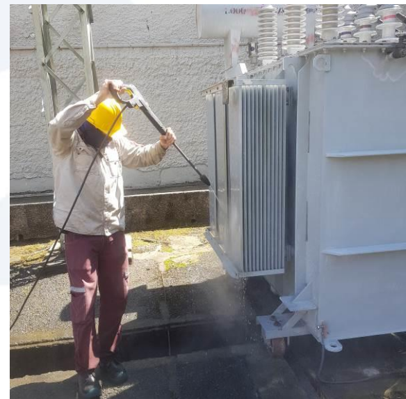
Fig.29. Limpieza de transformador en subestación.
