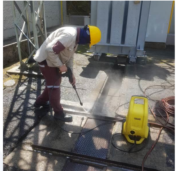
Fig.31. Limpieza de cárcamos en subestación.
