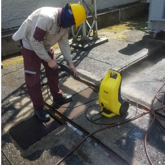
Fig.30. Limpieza de cárcamos en subestación.
