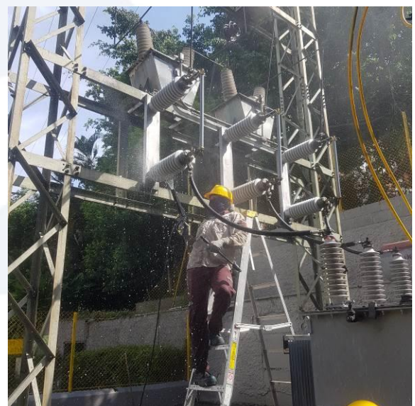
Fig.25. Limpieza de pórtico en subestación.
