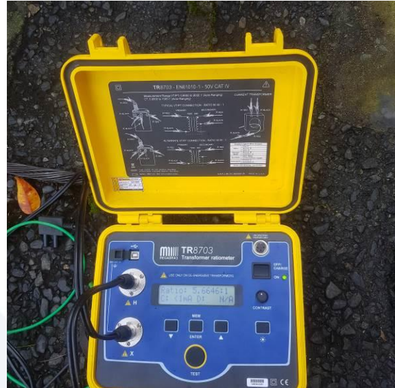
Fig. 11. Prueba de relación de transformación a transformador.
