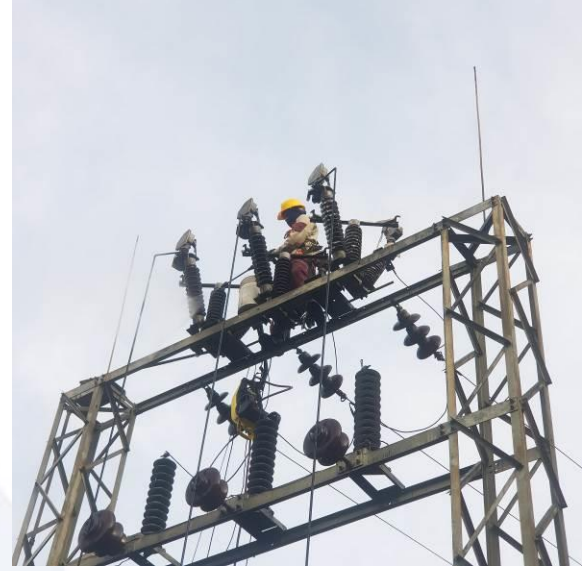
Fig.23. Limpieza de pórtico en subestación.
