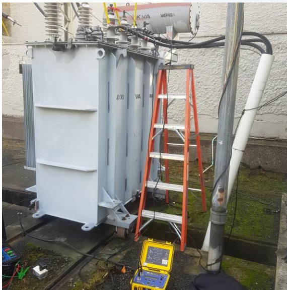
Fig. 12. Prueba de relación de transformación a transformador.
