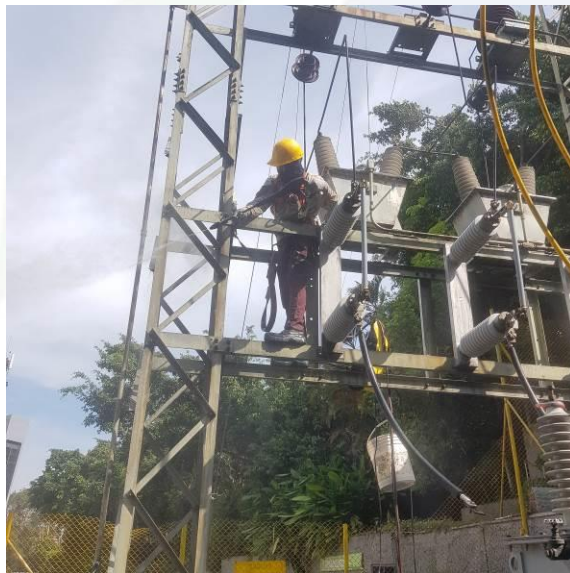
Fig.24. Limpieza de pórtico en subestación.
