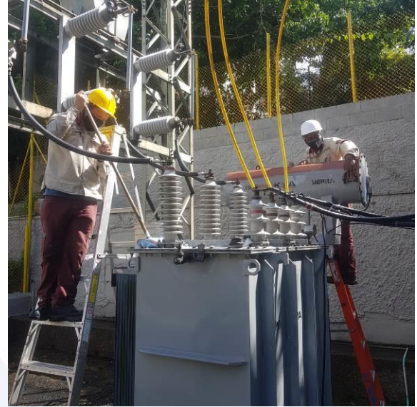
Fig.27. Limpieza de transformador en subestación.
