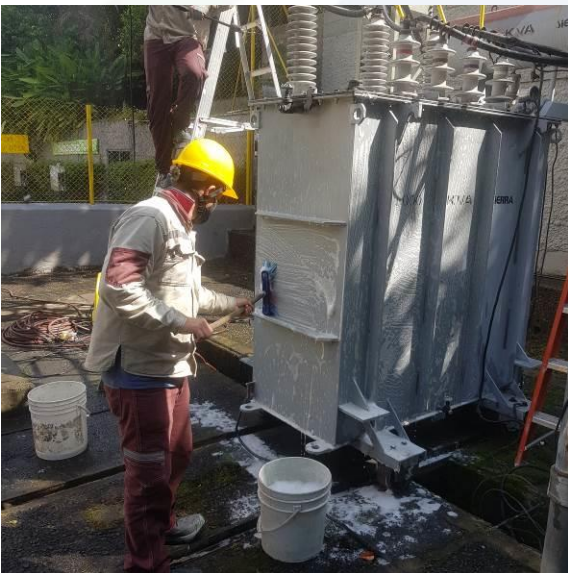
Fig.28. Limpieza de transformador en subestación.
