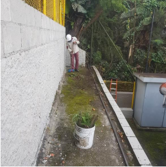
Fig. 18. Desmalezada y limpieza general de subestación.
