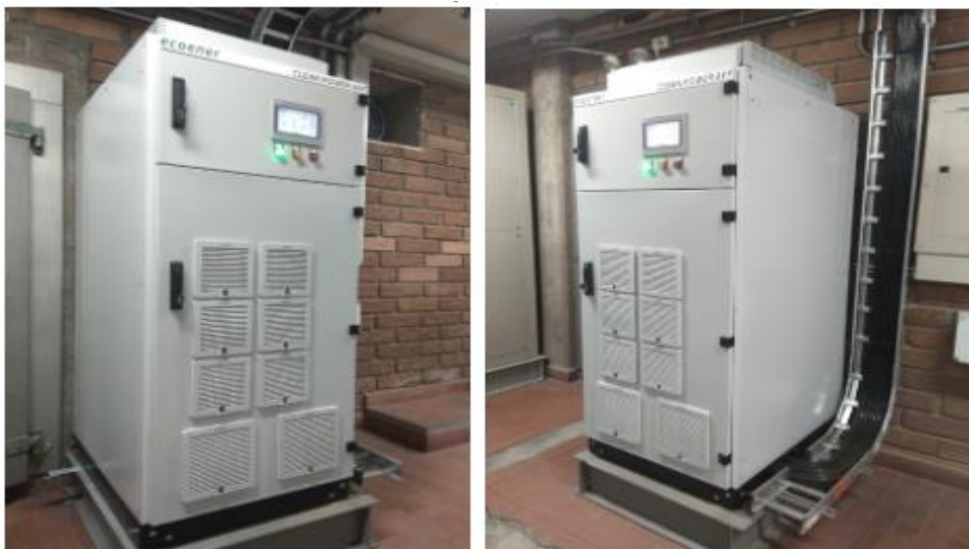
Figura 35. Vista de la instalación estructural del filtro activo [Fuente propia].
