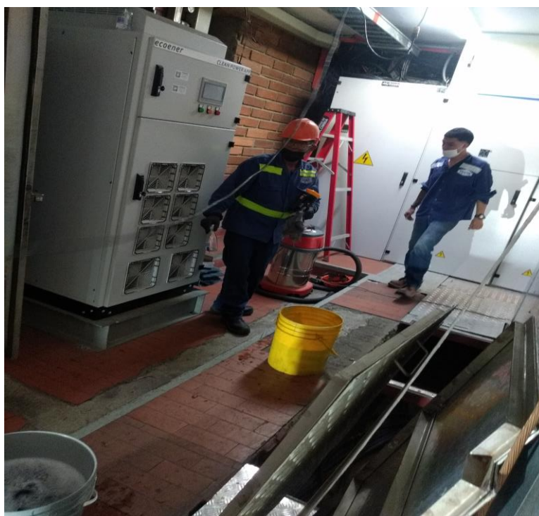
Figura 34. Instalación del filtro activo a la red de Colcafé [Fuente propia].
