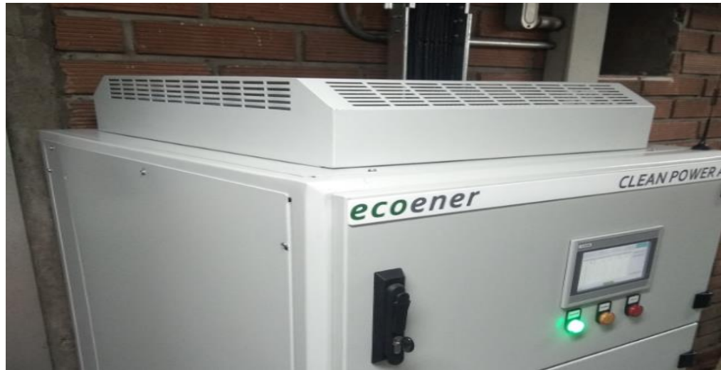
Figura 39. Instalación de nuevas rendijas de extracción de calor [Fuente propia].
