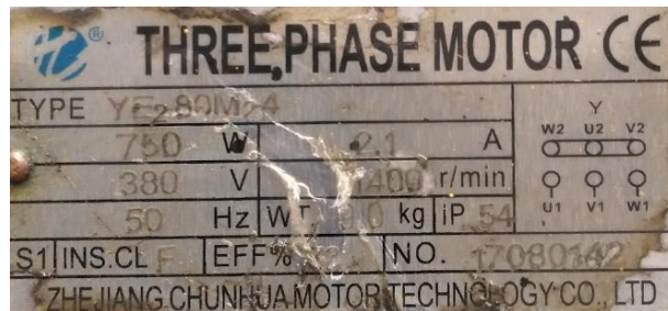
Imagen 24 - Placa de motor trifásico
