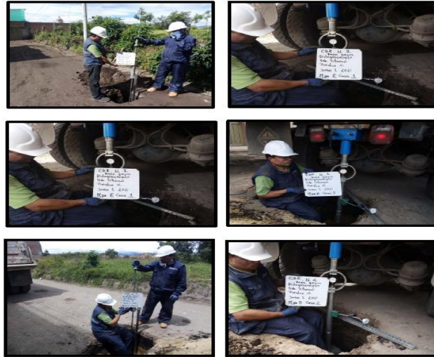
Figura 5. Apiques para estudio de suelos
