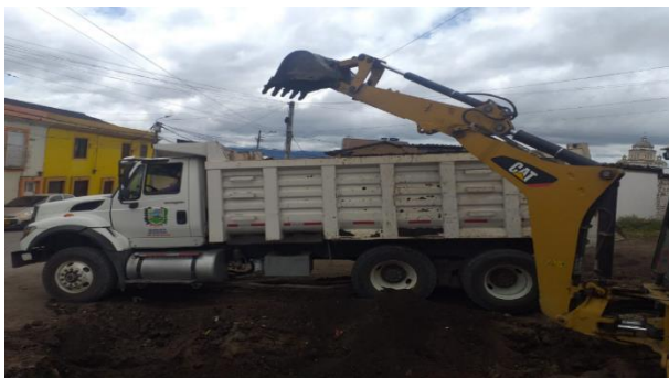
Figura 19. Acarreo de material de escarificación Fuente: Elaboración propia
