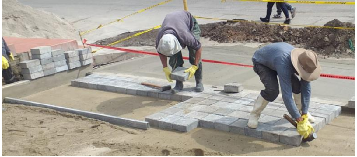
Figura 33. Colocación de adoquín Fuente Elaboración propia
