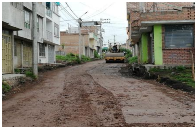
Figura 27. Conformación de capa base Fuente: Elaboración propia
