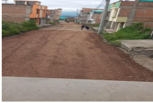
Figura 14. Capa de mejoramiento en afirmado Fuente: Elaboración Propia
