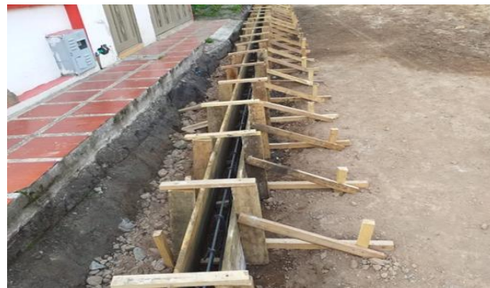
Figura 29. Formaletas para bordillo Fuente: Elaboración propia
