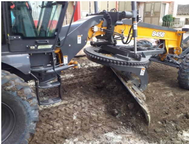
Figura 22. Excavación Fuente: Elaboración Propia
