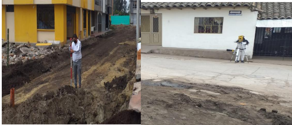
Figura 17. Toma de niveles y topografía Fuente: Elaboración propia
