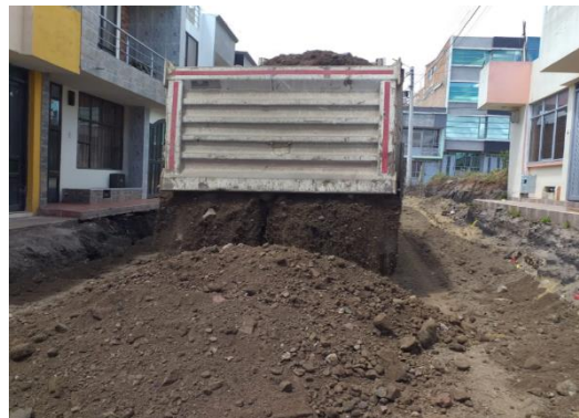
Figura 25. Riego de material Fuente: Elaboración propia
