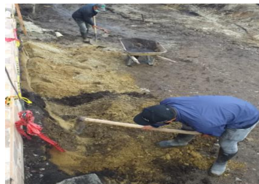
Figura 20. Excavación a mano Fuente: Elaboración propia
