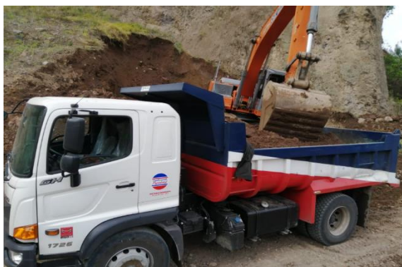
Figura 24. Mina de material de afirmado Fuente: Elaboración propia
