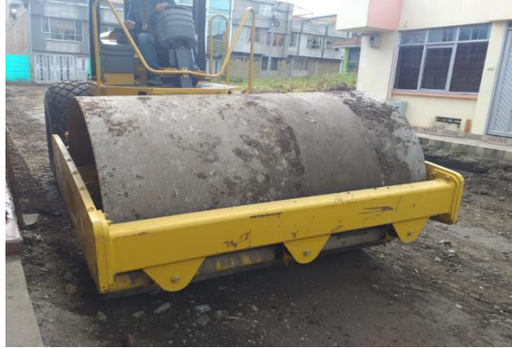
Figura 26. Compactación de vía Fuente: Elaboración propia
