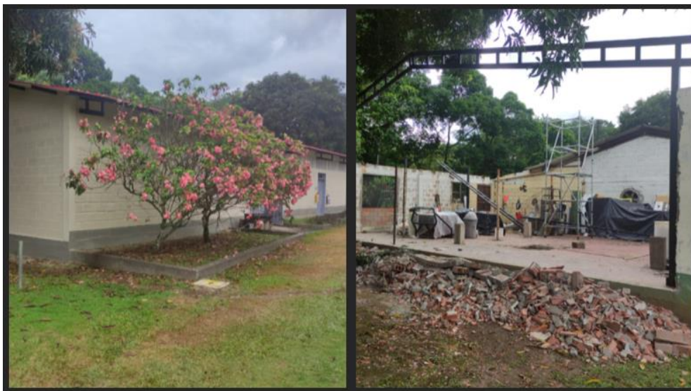
Ilustración 13: Remodelación de bodegas sede central.
