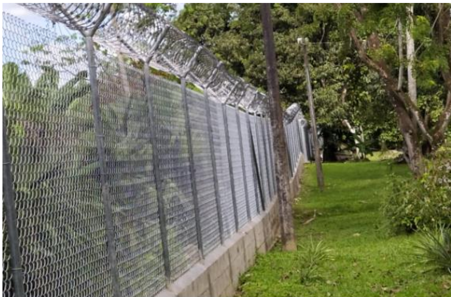
Ilustración 14: Reconstrucción de malla de cerramiento Sede central
