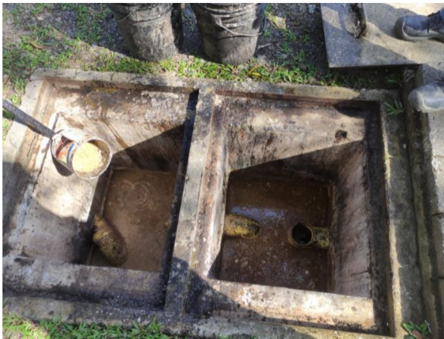
Ilustración 8: Limpieza de trampa de grasa de Sede Social
