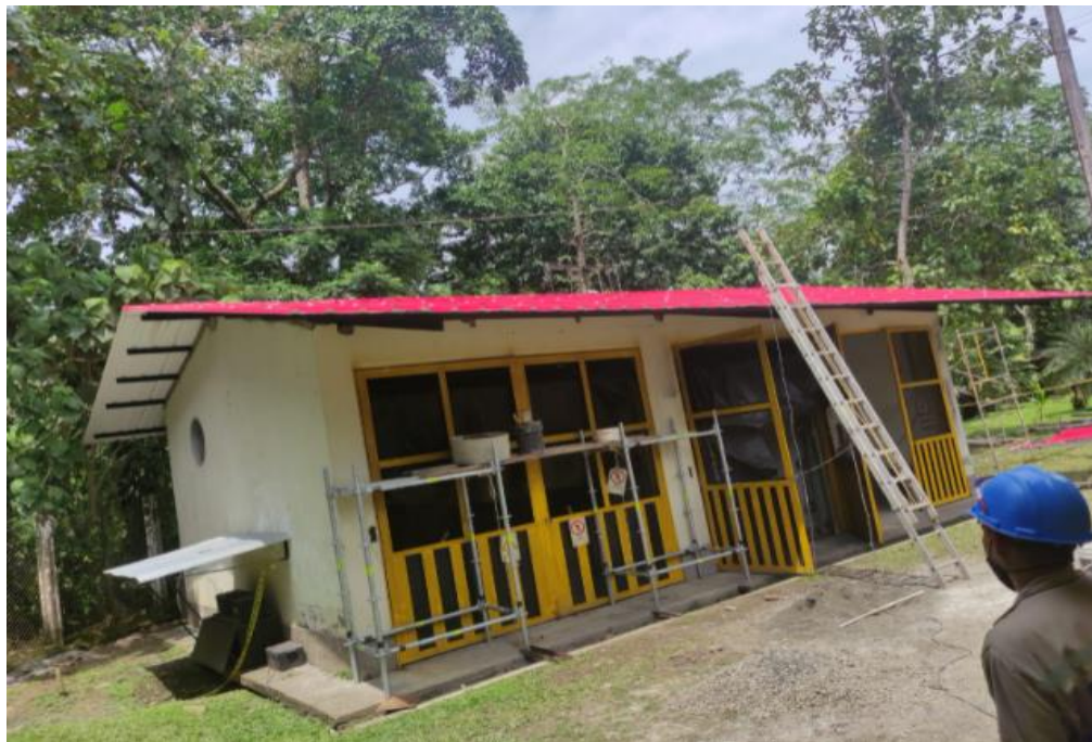
Ilustración 7: Cambio de cubierta de subestación eléctrica.
