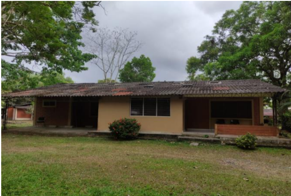
Ilustración 5: Casa 21 del campamento de UNIBAN central.
