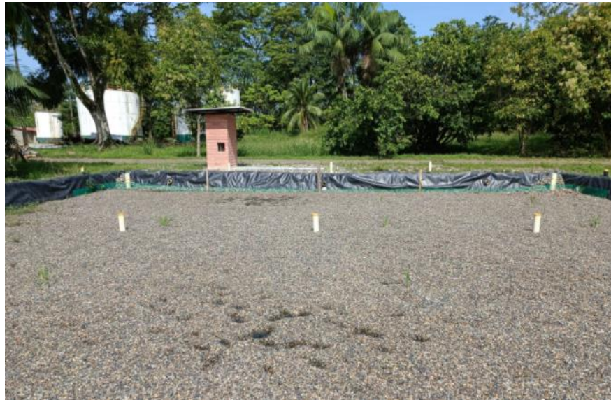
Ilustración 3: Humedal de gravas Zona industrial
