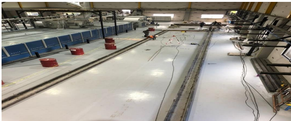
Figura 37: Mortero ya vaciado y listo para montaje de lámina base.
