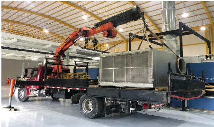
Figura 15: Logística e izado de la máquina de un nivel a otro por medio de grúa.
