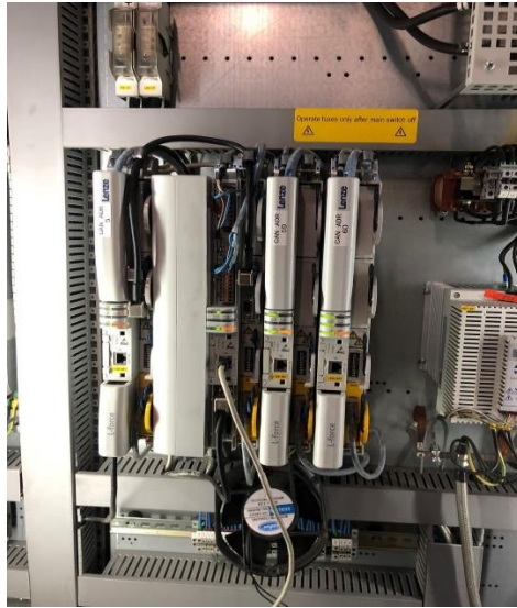
Figura 39: Variadores Lenze reemplazados en rama textil.
