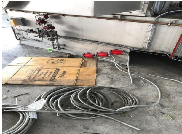
Figura 10: Instalación de clavijas para la conexión de la máquina con el tablero eléctrico.
