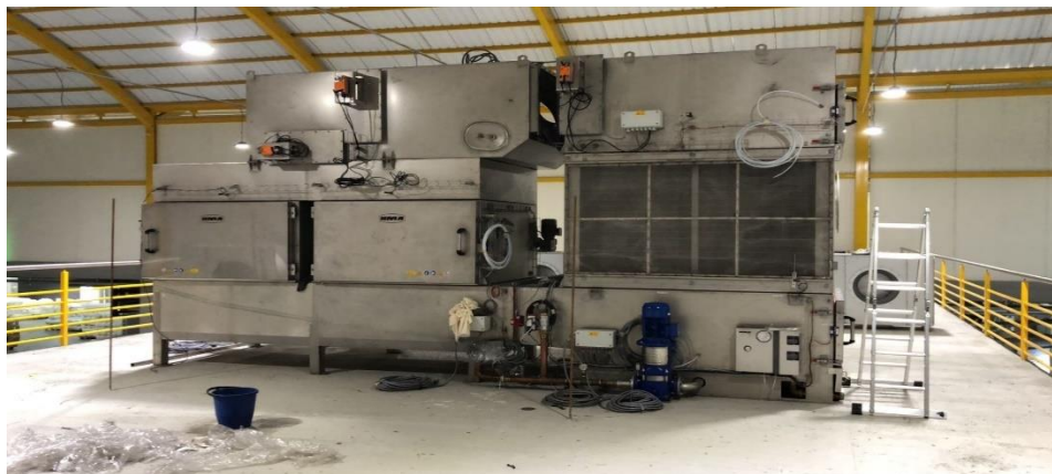
Figura 16: Maquina KMA Ensamblada mecánicamente y lista en sitio de operación.
