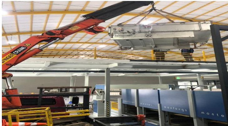
Figura 14: Izado de los componentes del equipo con ayuda de una grúa.
