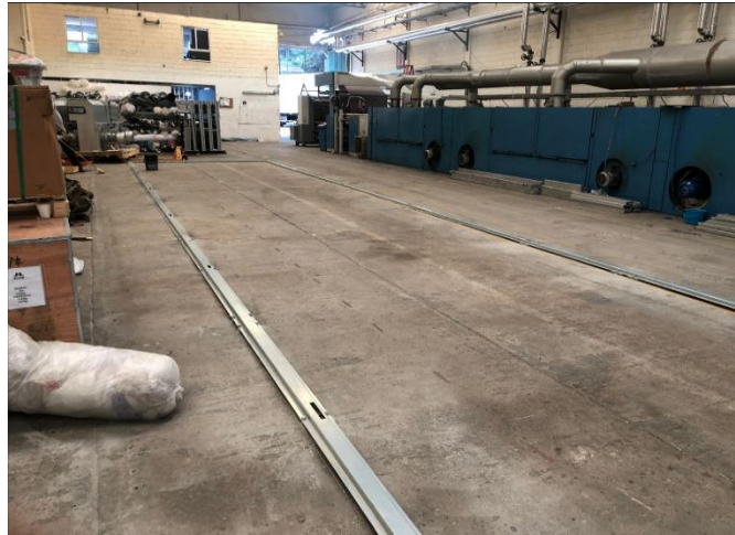
Figura 19: Instalación del riel base para la instalación de la Rama Textil.
