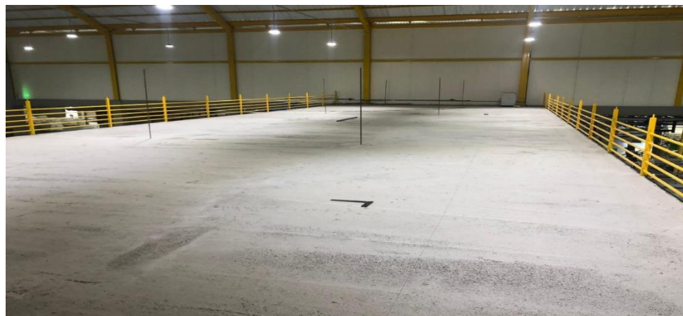
Figura 13: Loza donde se realizará el montaje del equipo KMA.
