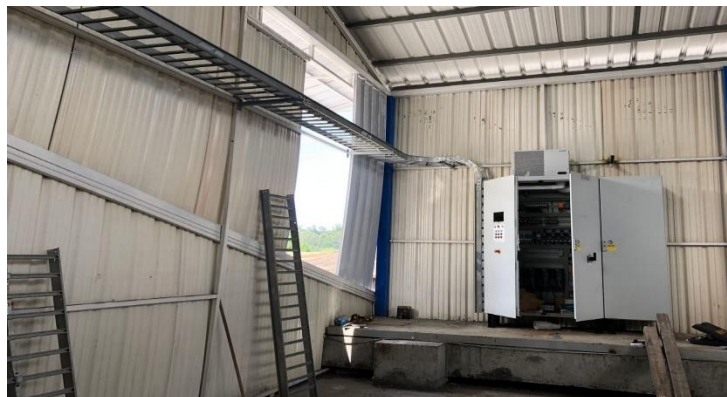
Figura 6: Instalación de bandeja porta cables.
