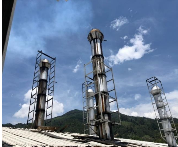
Figura 3:Chimeneas realizando el arrojo de los residuos producto del proceso de termo fijación.
