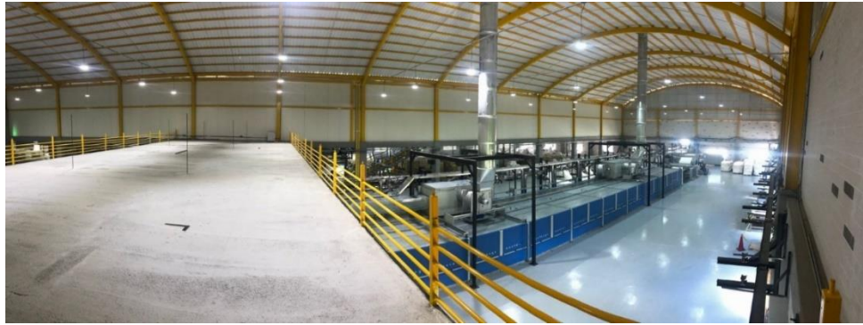
Figura 12: Planta física de la empresa donde se realiza el montaje.
