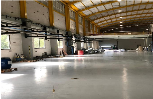
Figura 36: Planta física con el trazado de los planos en la loza.
