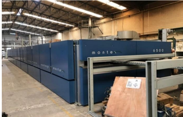
Figura 23: Zona de hornos con instalación de paneles externos.
