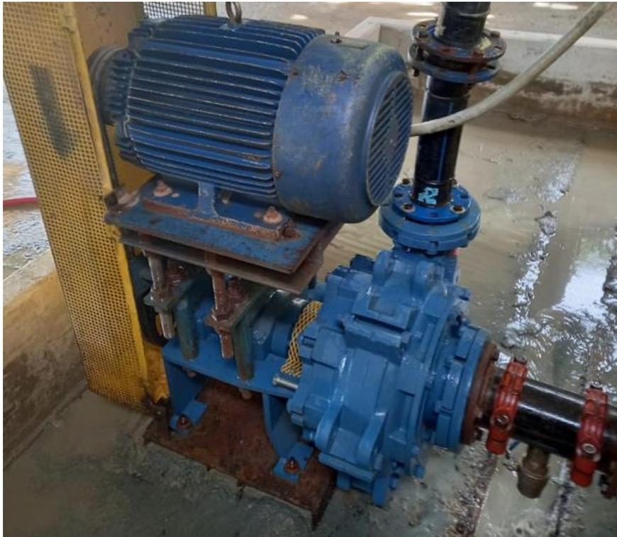
Figura 21. Bomba centrífuga 6" X 4". Fuente. (Touchstone Colombia)
