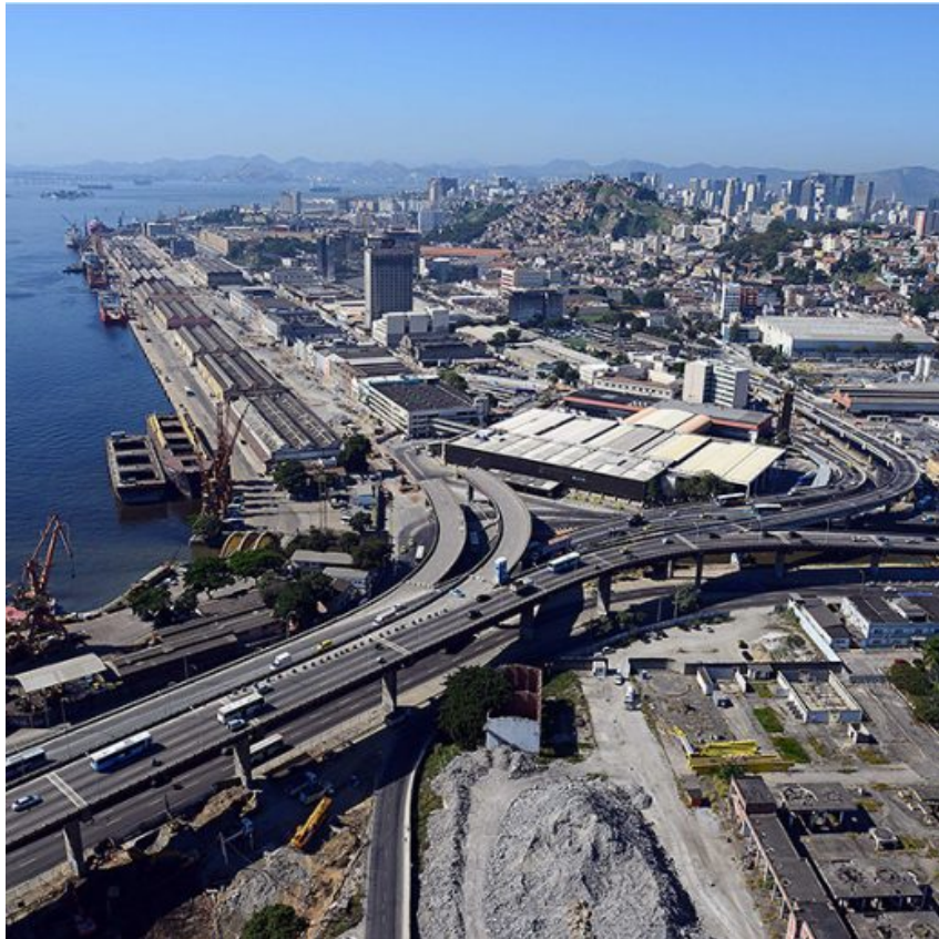
Ilustración 5 Zona de intervención de Porto Maravilha, Brasil
