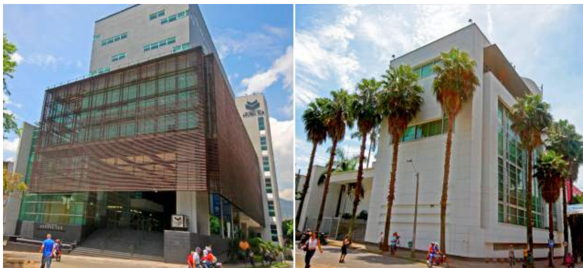
Ilustración 11 Edificios de la Cámara de Comercio Aburrá Sur
