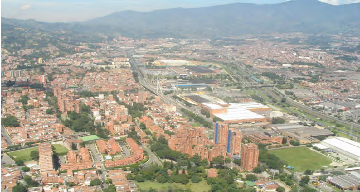
Ilustración 1 Panorámica actual de la zona de intervención de la Centralidad Sur
