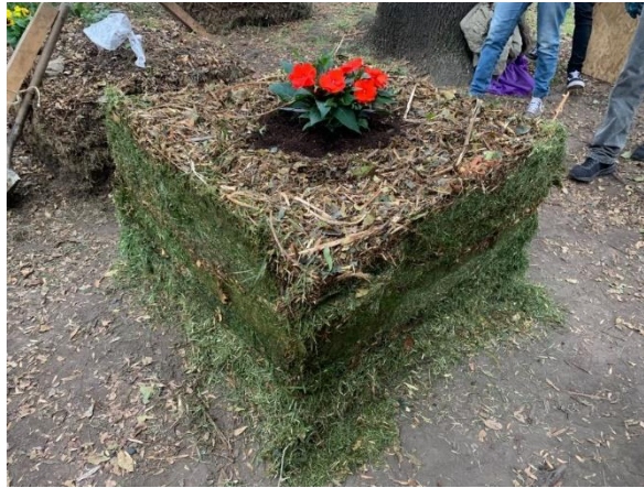
Figura 16. Instalación de planta ornamental sobre una Paca Digestora Silva recién culminada.
