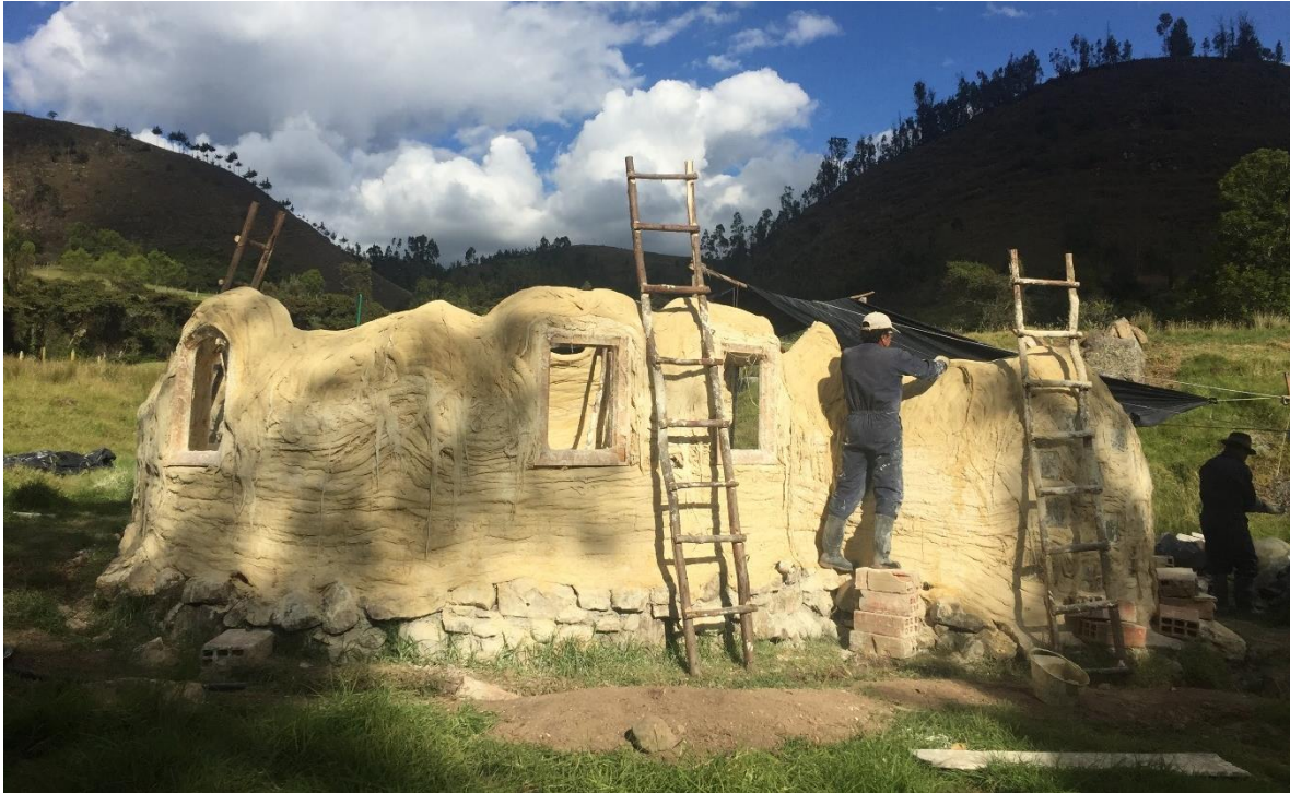
Figura 20 “Kerterre” en construcción
