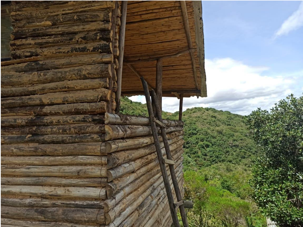
Figura 43 Muros hechos en magué
