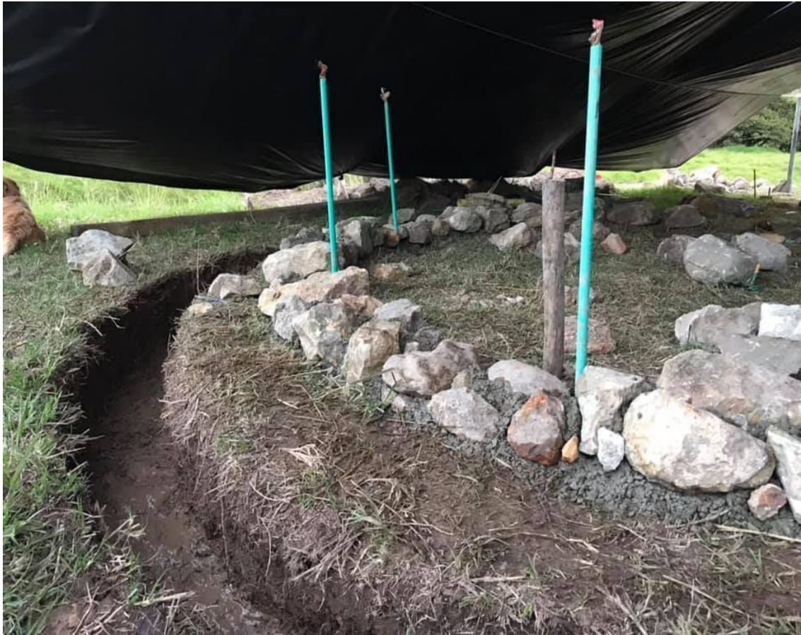
Figura 14 Preparación de cimientos y zócalos.
