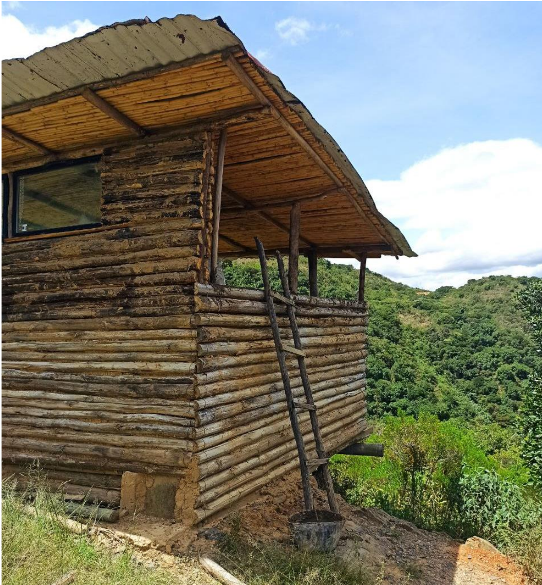
Figura 42 Muros hechos en magué
