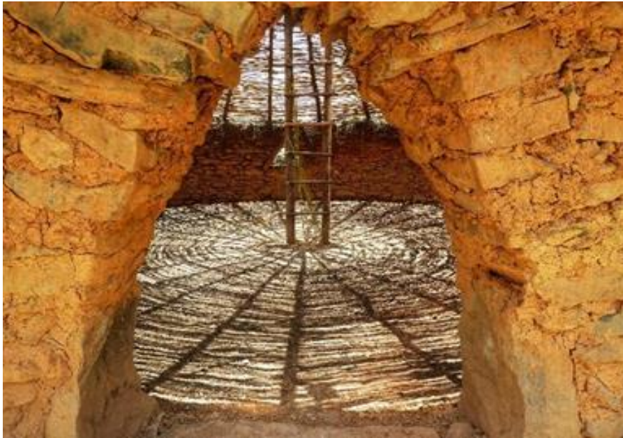
Figura 39 Construcción del techo de la “Maloca”
