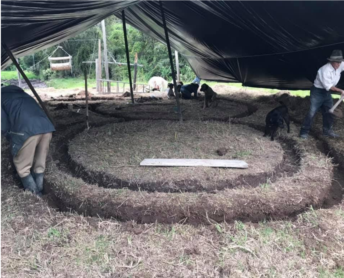
Figura 13 Preparación de cimientos
