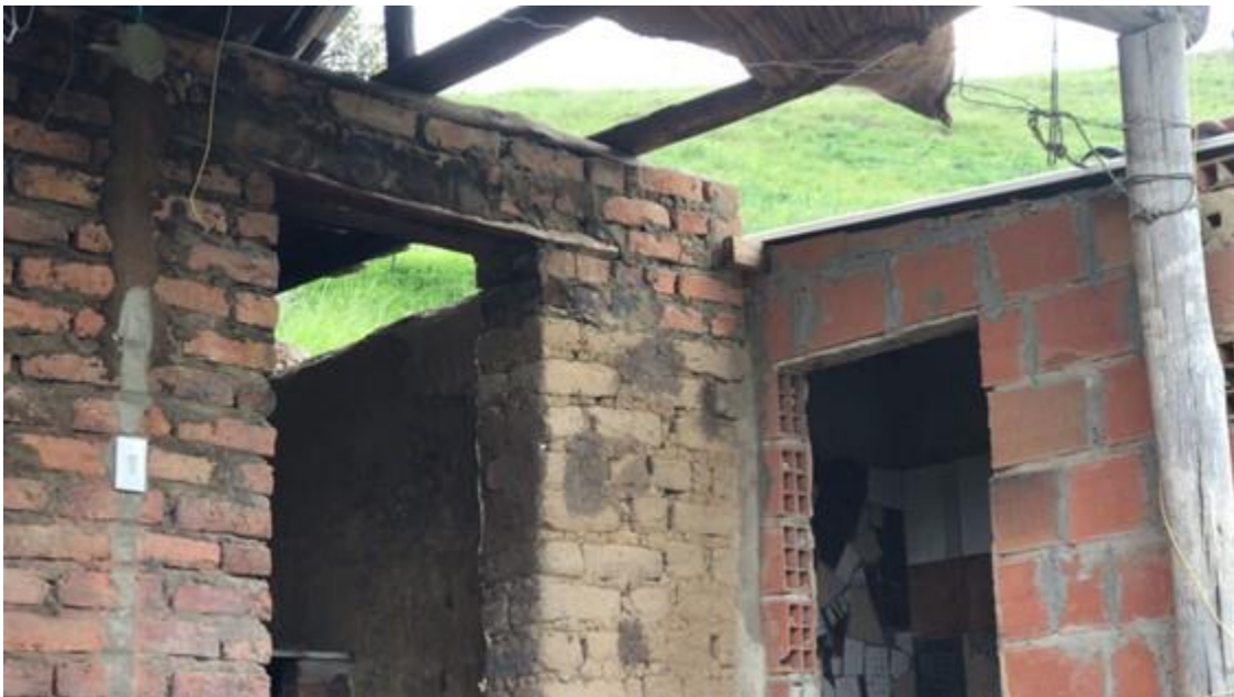
Figura 35 Variedad de tipos de materiales en los muros
