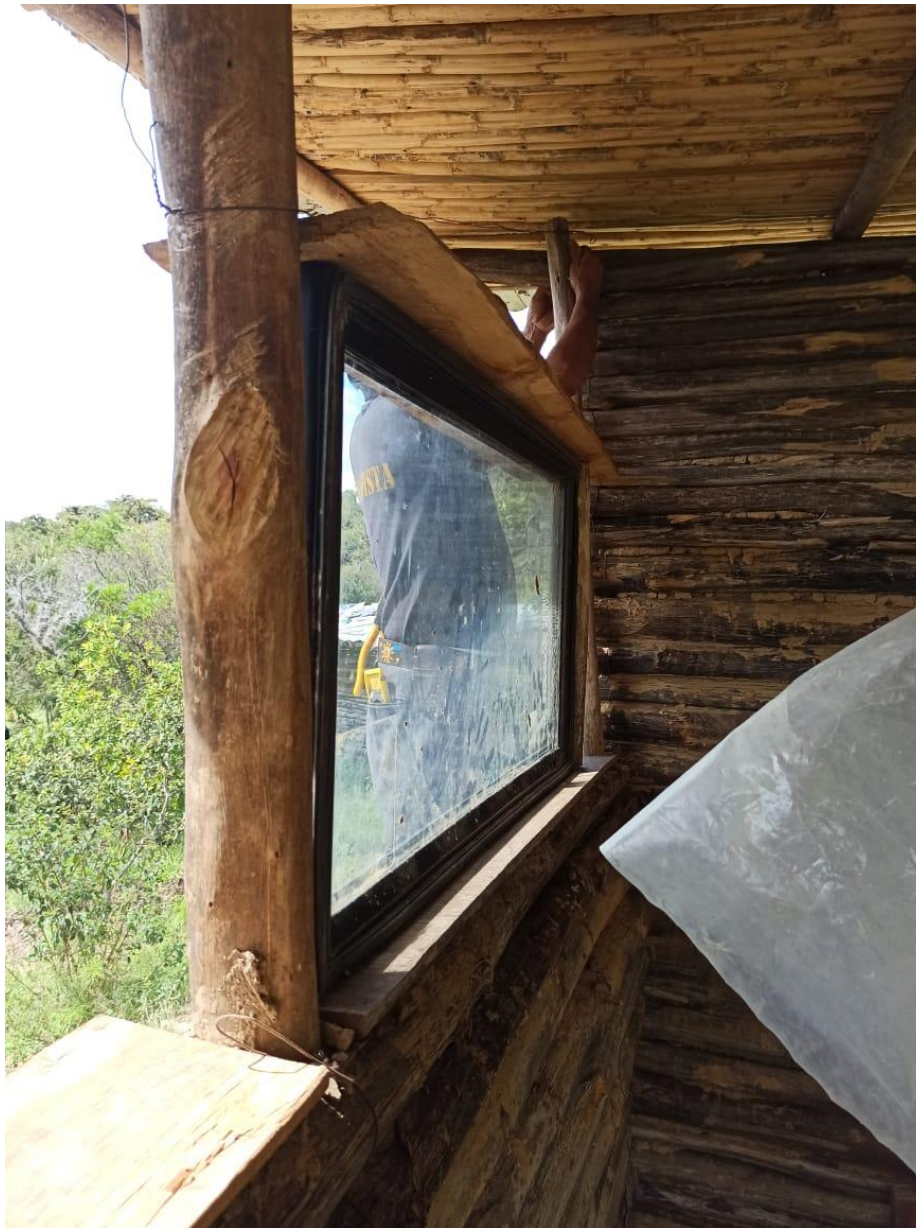
Figura 44 Instalación de la ventana
