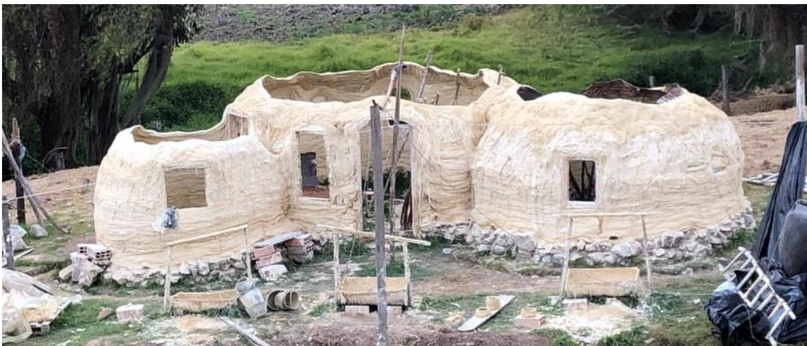
Figura 22 Palos, tejas y tablas sosteniendo la estructura
