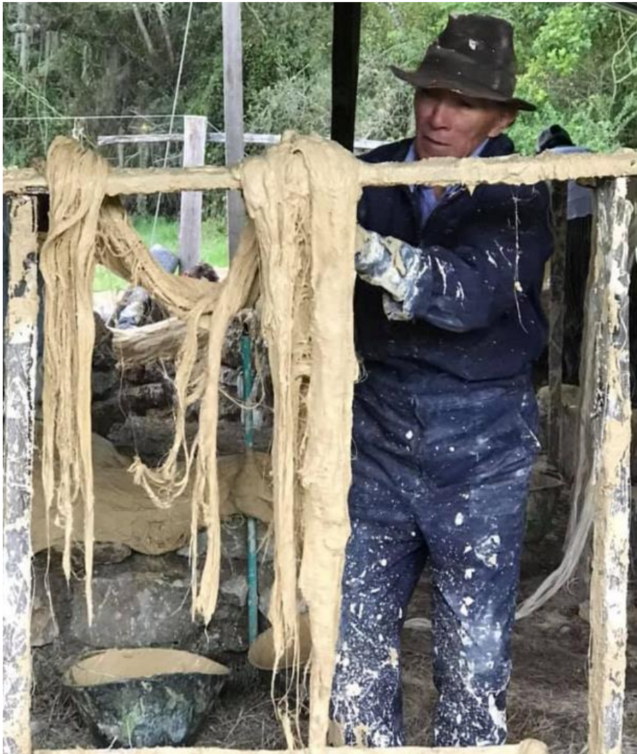
Figura 17 Morteros adecuados para escurrir los excesos de mezcla
