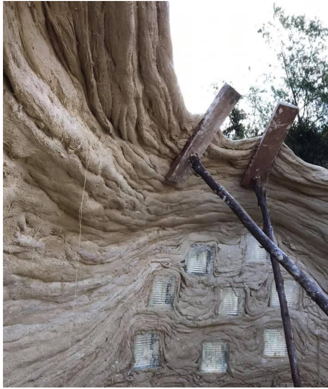
Figura 21 Palos y tablas sosteniendo la estructura
