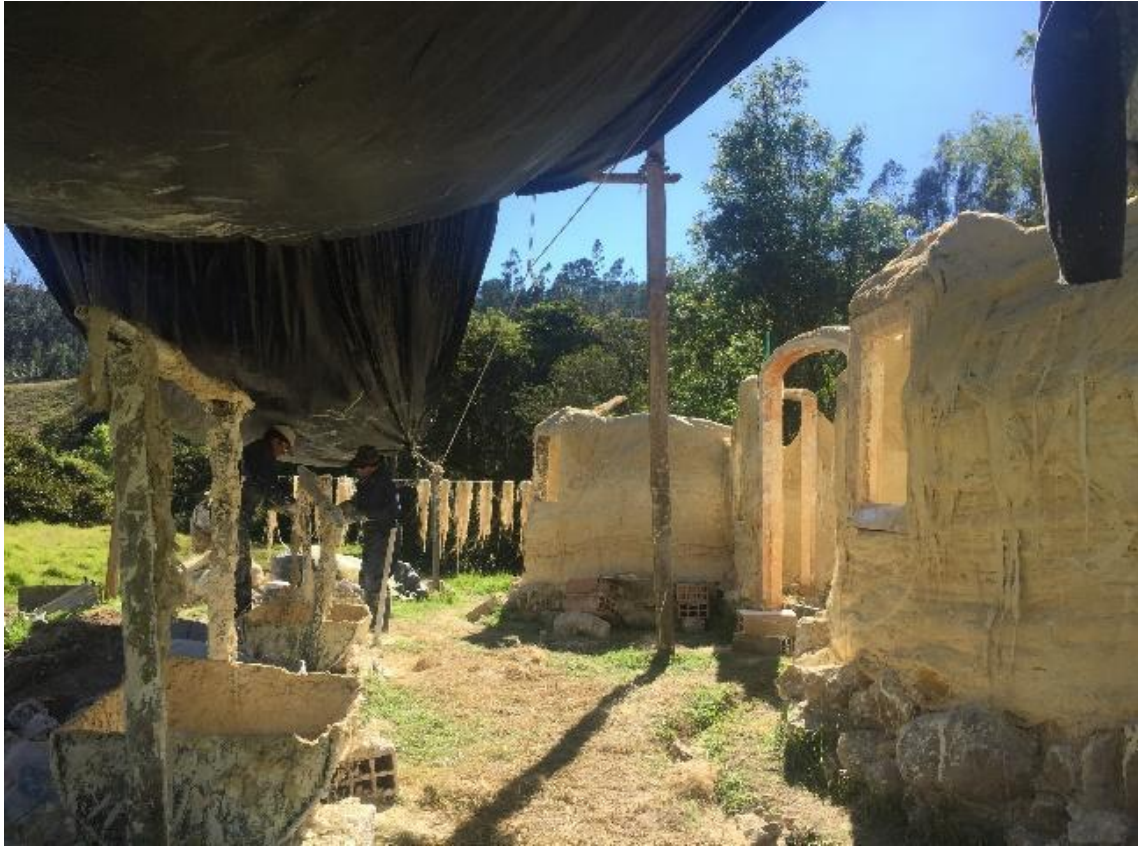
Figura 19 “Kerterre” en construcción
