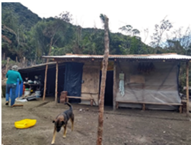
Figura 2. Vivienda autoconstruida por participante C
