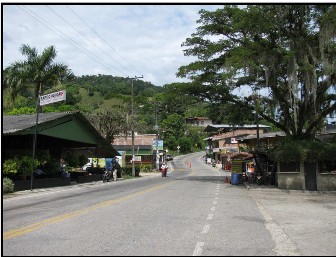
Ilustración 15. Corregimiento Puerto Nus, municipio de Maceo. Servicios de carretera. Fuente: la investigación.
