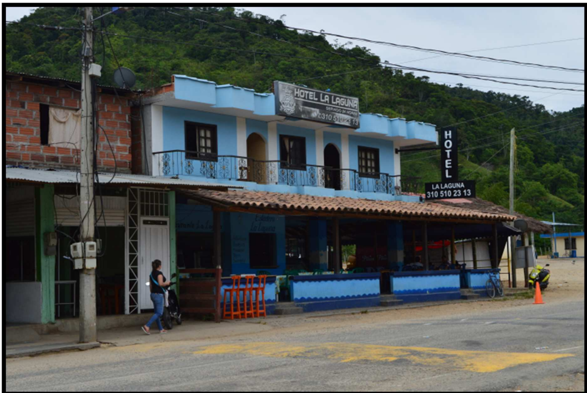
Ilustración 14. Corregimiento La Floresta del municipio de Maceo. Servicios de Carretera. Fuente: la investigación.
