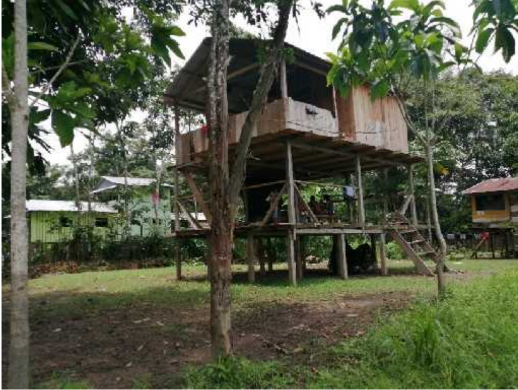
Fotografía 52. Dimensiones de una casa en palafito, normalmente en los pisos altos está la vivienda, en los pisos bajos el comedor o las zonas de estar.
