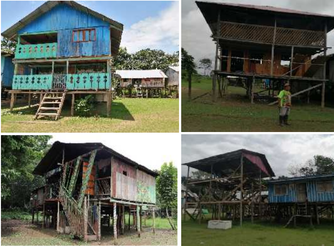
Ilustración 15. Formas de construcción de la casa en palafito en la Isla de la Fantasía.
