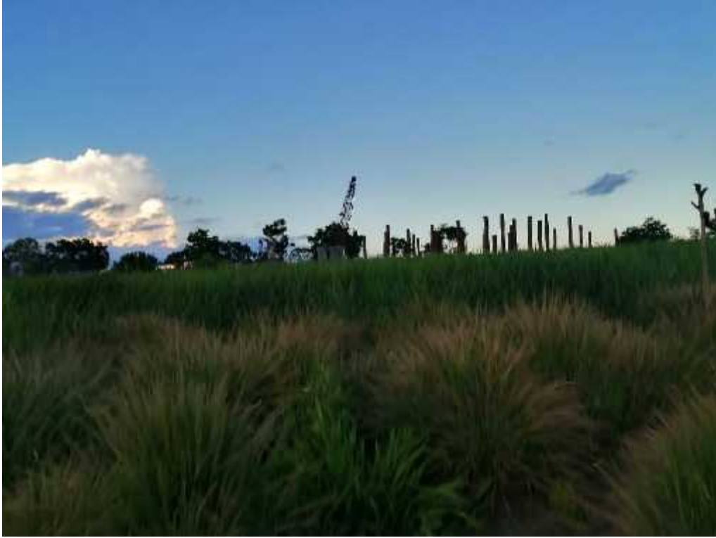
Fotografía 66. Construcción abandonada en temporada de sequía.
