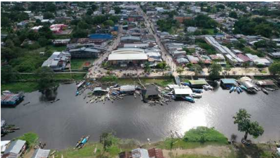
Toma de drone 4. Vista desde arriba del Malecón turístico, el Canal de la Fantasía y la Plaza de Mercado Cortesía Angela Trujillo, drone mavic 2 pro, 25 de marzo de 2021, Gestión del riesgo por peligro aviario y de la fauna. Aeropuerto Internacional Vásquez Cobo.
