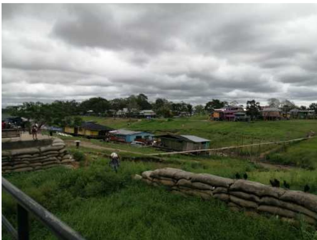
Fotografía 54. puente construido por la comunidad de la Isla de la Fantasía en cabeza de su JAC.
