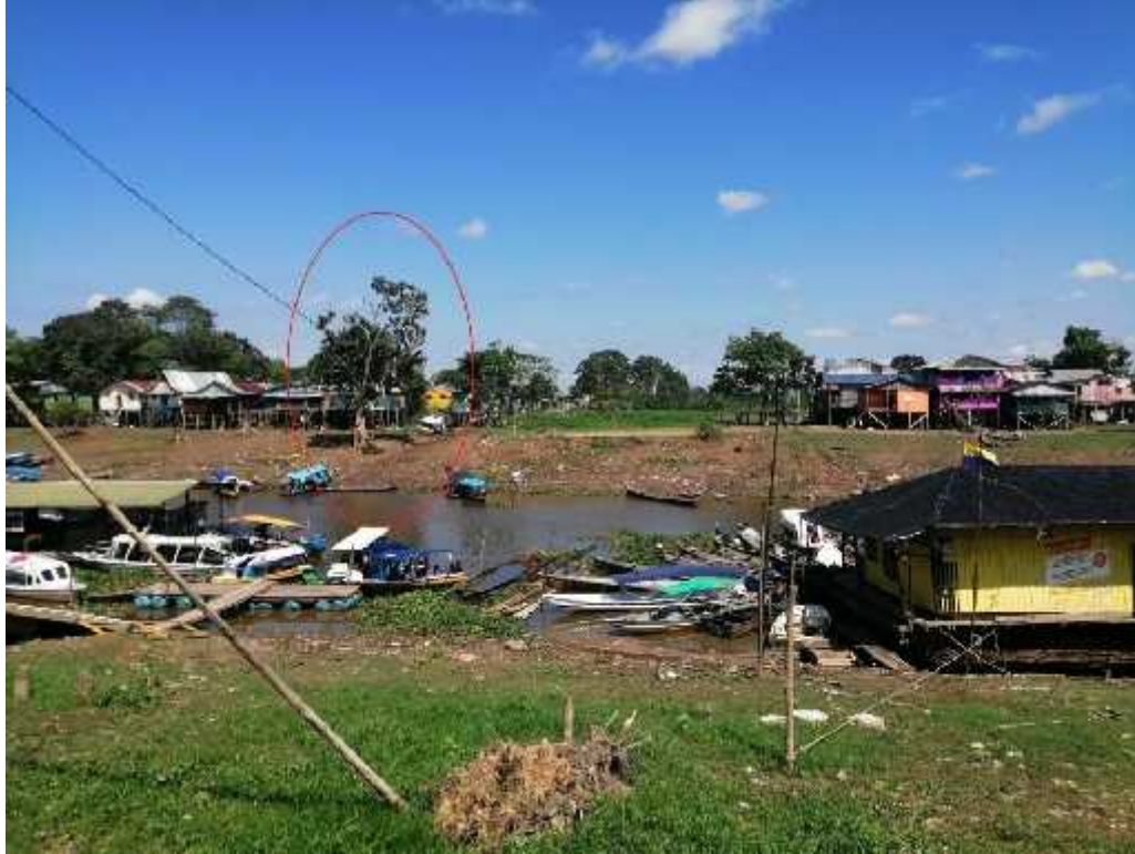
Fotografía 44. Época de sequía o bajo caudal de las aguas del río Amazonas en la Isla de la Fantasía. El árbol marca el nivel de la cota de agua.
