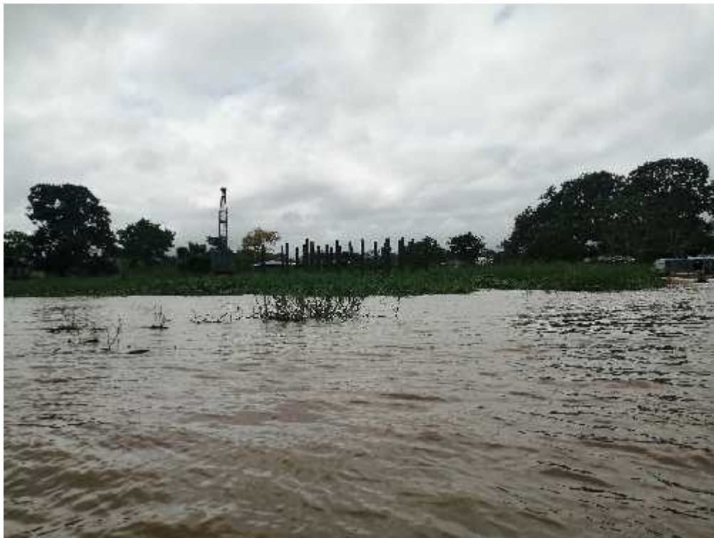
Fotografía 67. Construcción abandonada en tiempos de inundación.
