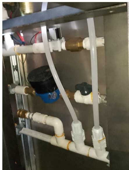
Ilustración 25. Sistema adaptación tubería.
