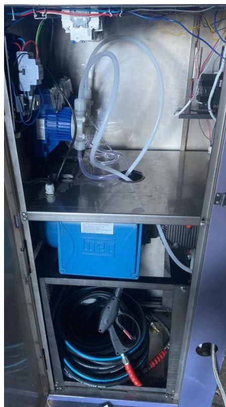
Ilustración 29. Vista frontal autolavado.
