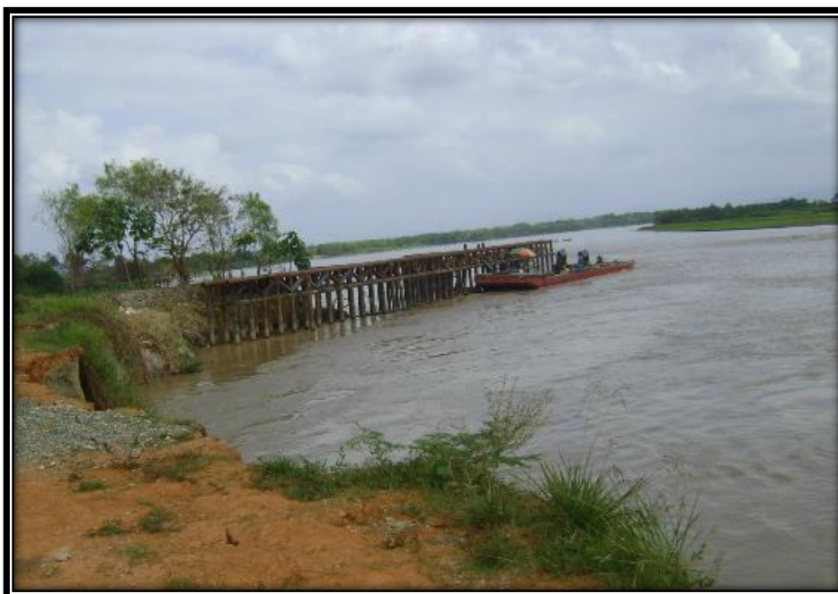
Ilustración 6: Muro de contención perpendicular al río.
